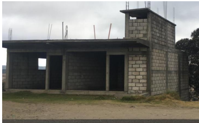
Figura 10. Construcción de block
