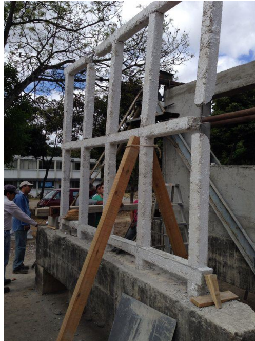
Figura 21. Marco interno de concreto del panel
