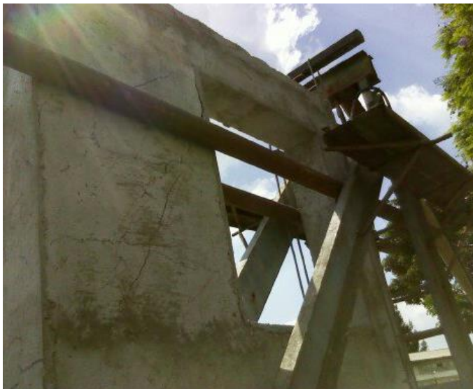
Figura 47. Ensayo de muro con ventana
