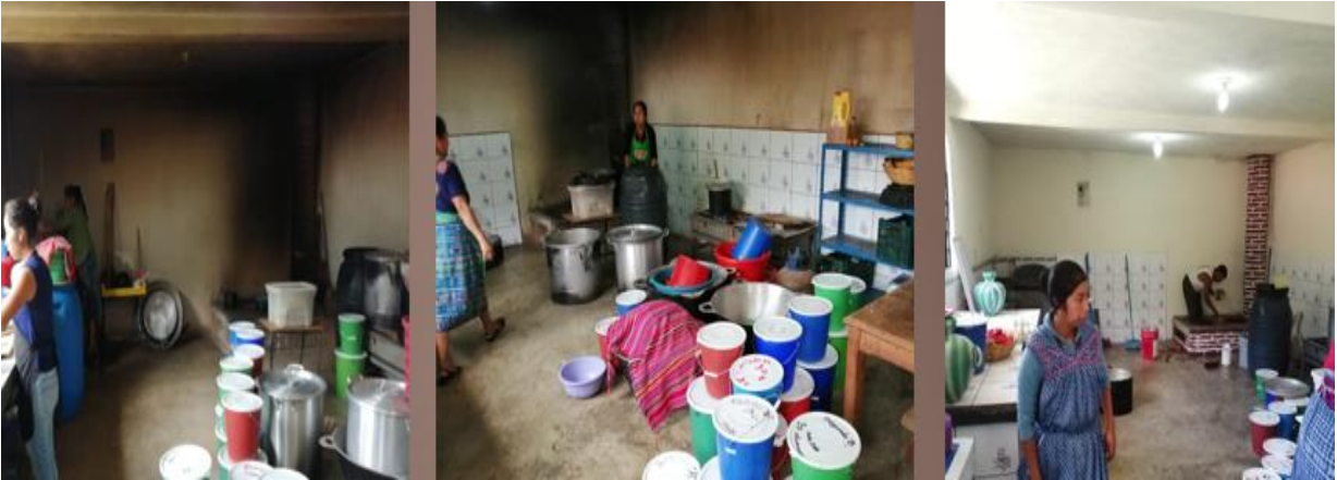
Fuente: Proyecto comunitario: Remodelación cocina de la Escuela Oficial Urbana Mixta El Calvario. Antes, durante y después. EPS 2019.
