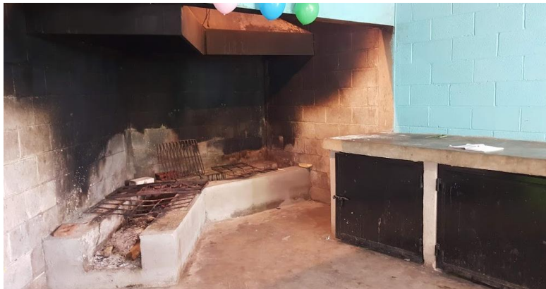
Proyecto comunitario Remodelación de cocina escolar Chicacao, Suchitepéquez
