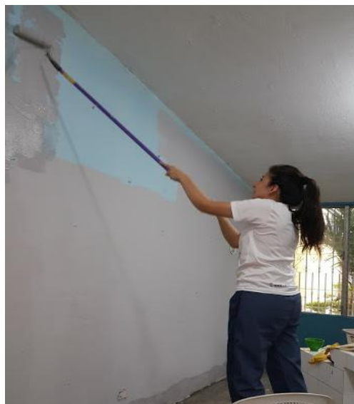
Proyecto de mejoras a clínica: aplicación de pintura
