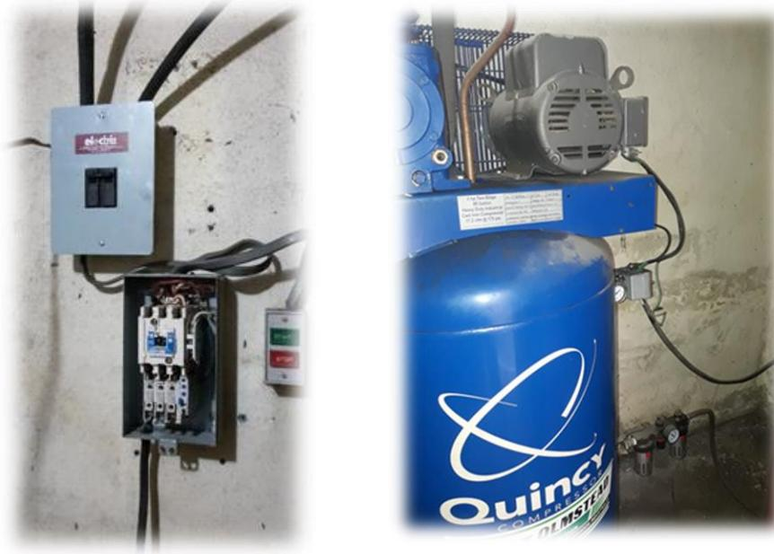
Fotografías del cambio de dados, caja y mantenimiento del compresor dental de la clínica
