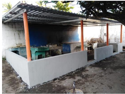
Fotografía 3 y 4. Cocina escolar: reconstrucción del techo y construcción de muro circular con amplitud de 2 metros cuadrados.
