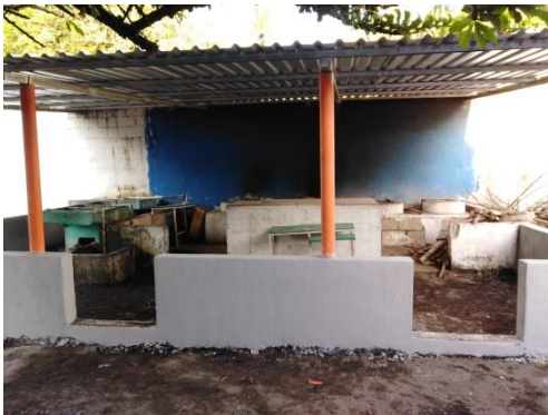
Fotografía 3 y 4. Cocina escolar: reconstrucción del techo y construcción de muro circular con amplitud de 2 metros cuadrados.
