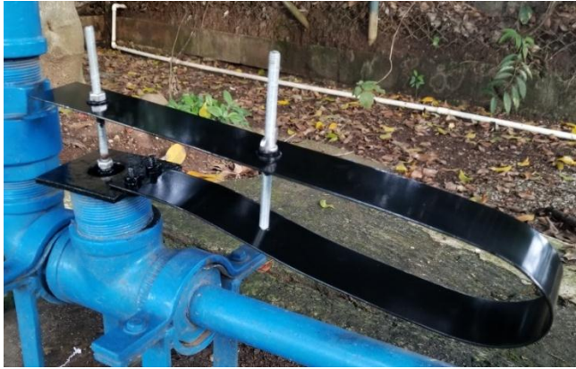
Figura 52. Nuevo muelle instalado
