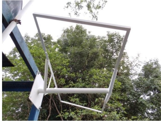
Figura 60. Instalación de soporte de panel fotovoltaico
