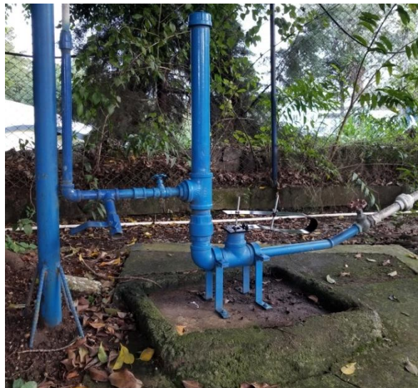
Figura 53. Ariete hidráulico finalizado
