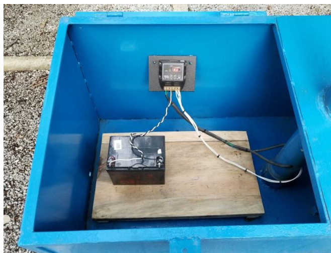
Figura 41. Reconexión del sistema eléctrico
