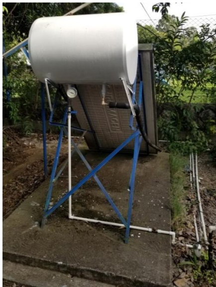
Figura 57. Colector solar finalizado
