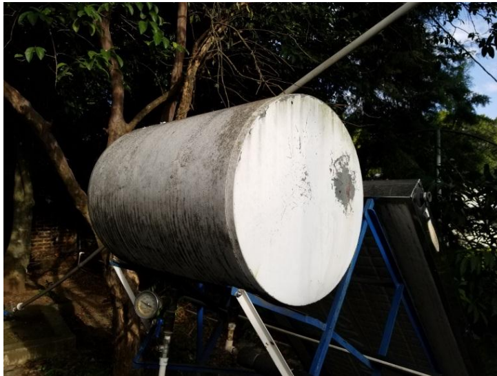
Figura 55. Tanque de almacenamiento antes
