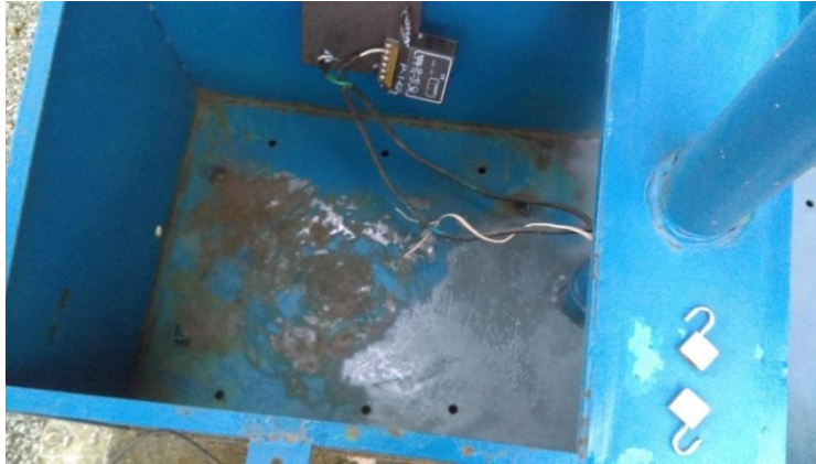
Figura 39. Interior de contenedor proceso de lijado
