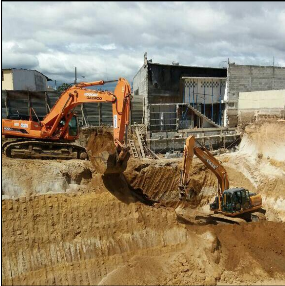
Figura 5. Excavación de sótano
