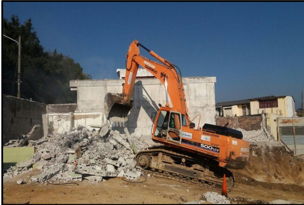
Figura 3. Demolición y excavación
