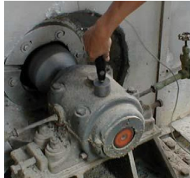
Figura 28. Colocación del sensor en dirección vertical
