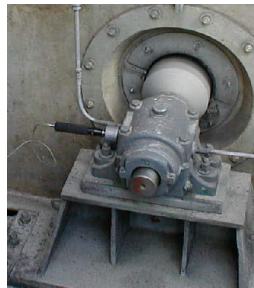
Figura 29. Colocación del sensor en dirección horizontal
