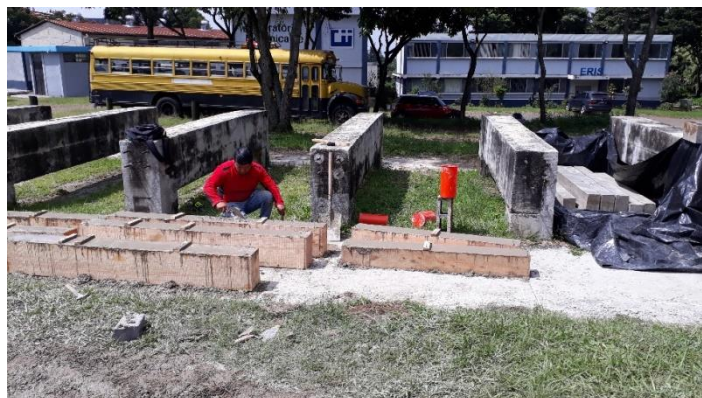
Figura 45. Armado de elementos columnas con azúcar como aditivo retardante
