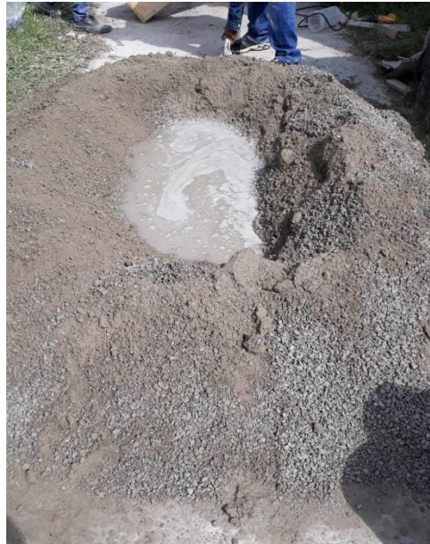
Figura 44. Fundición del hormigón del elemento columna con azúcar como aditivo retardante
