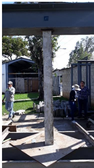
Figura 46. Colocación de elemento columna para ensayo a compresión
