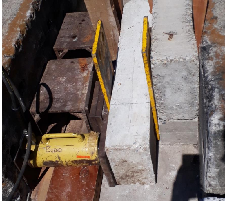
Figura 48. Colocación de elemento columna para ensayo a corte
