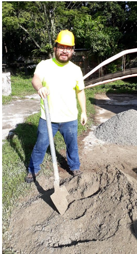
Figura 29. Fundición del hormigón para elemento columna
