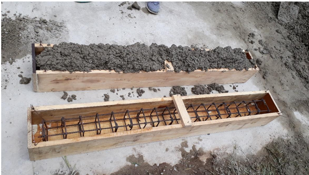
Figura 23. Elaboración del elemento viga
