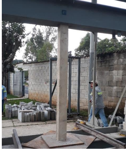
Figura 31. Colocación del elemento columna para ensayo a compresión
