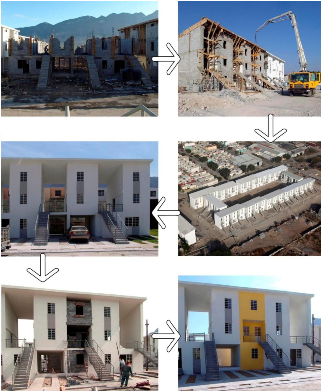
Figura 19. Proceso constructivo de la solución habitacional “Elemental Monterrey”.
