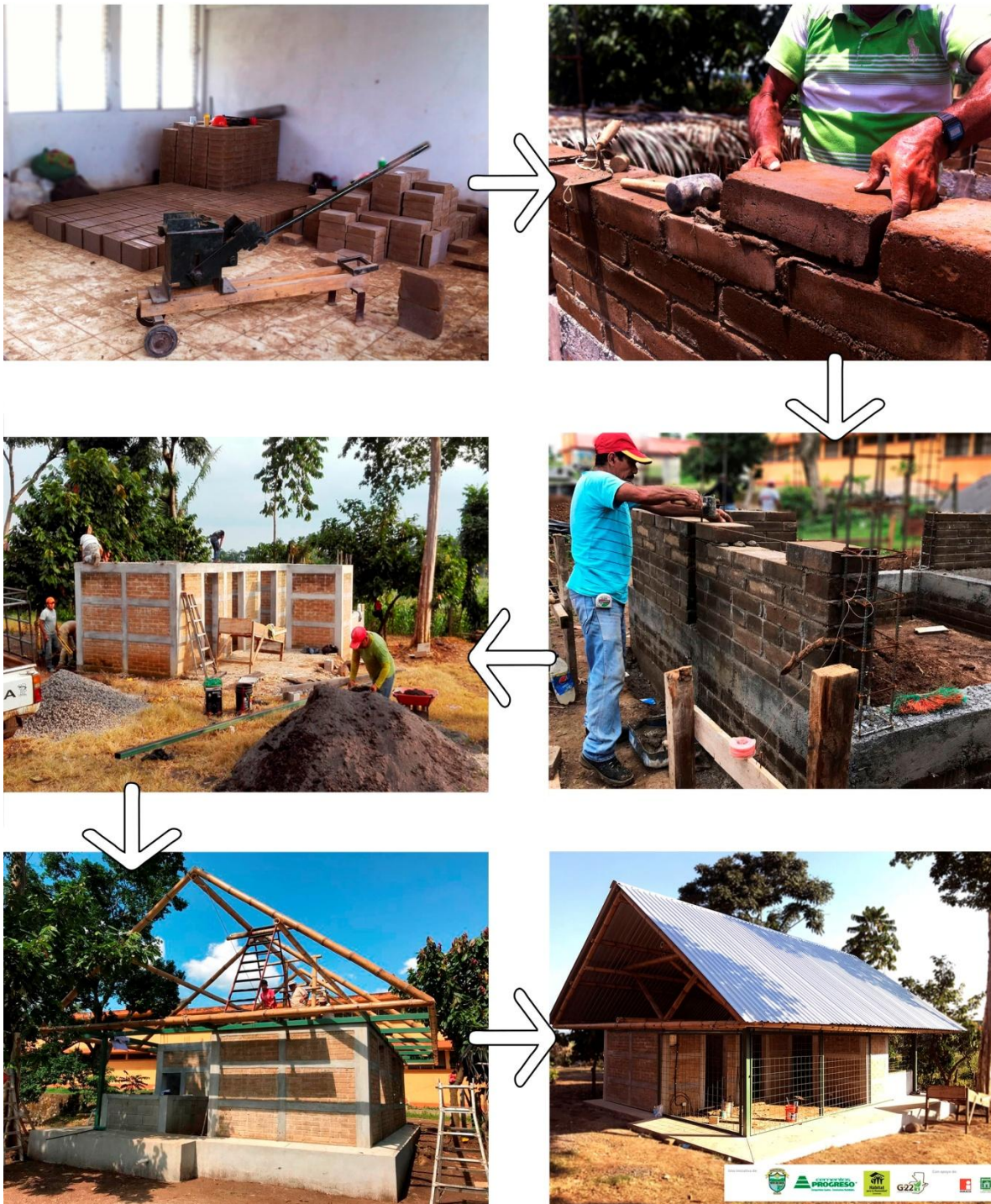
Figura 16. Proceso constructivo del prototipo de vivienda “Mi Hogar Sostenible”.
