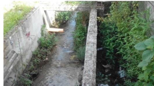
Imagen 3. Drenaje superficial intervenido. Colección propia, junio 2017.
