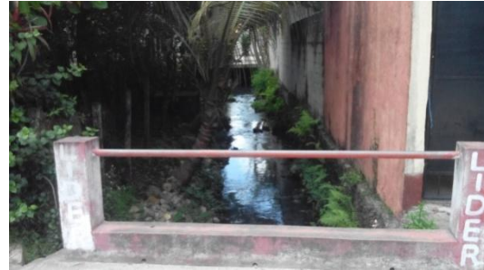
Imagen 2. Drenaje superficial entre viviendas. Colección propia, junio 2017.
