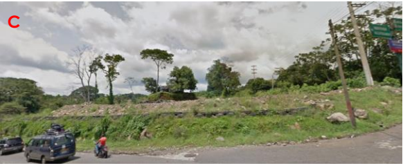
Figura 57: Vista suroeste del terreno ubicado sobre la CA2. Fuente: Google Maps.
