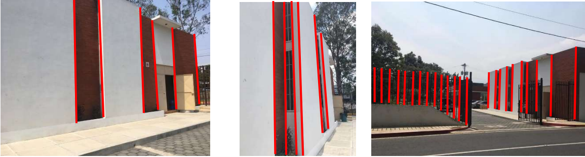
Imágenes No. 76, 77, 78 Análisis verticalidad construcciones aledañas. Elaboración propia.
