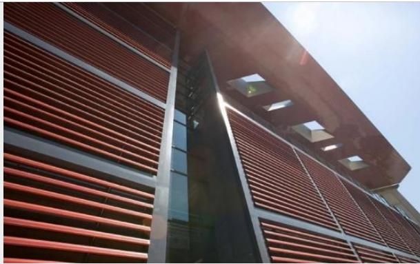
Voladizo de 36 metros en cubierta, sostenido por pilares de acero, es importante mencionar que el techo no se apoya en ningún momento sobre la estructura existente.
