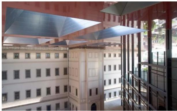
Protección solar metálica para las fachadas que permite la iluminación natural en cada edificación y a su vez la integración al conjunto.
