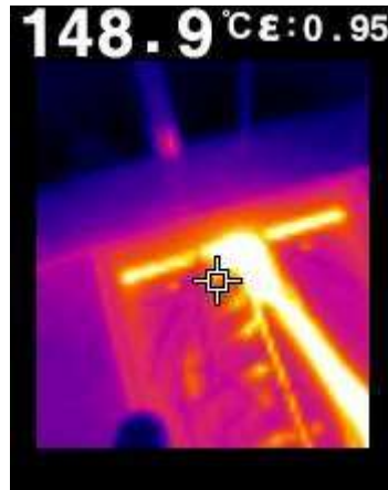
Figura 27. Medición mediante la técnica de termografía
