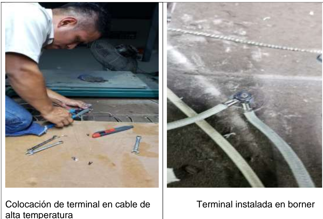
Figura 36. Cambio de terminal con técnico de mantenimiento
