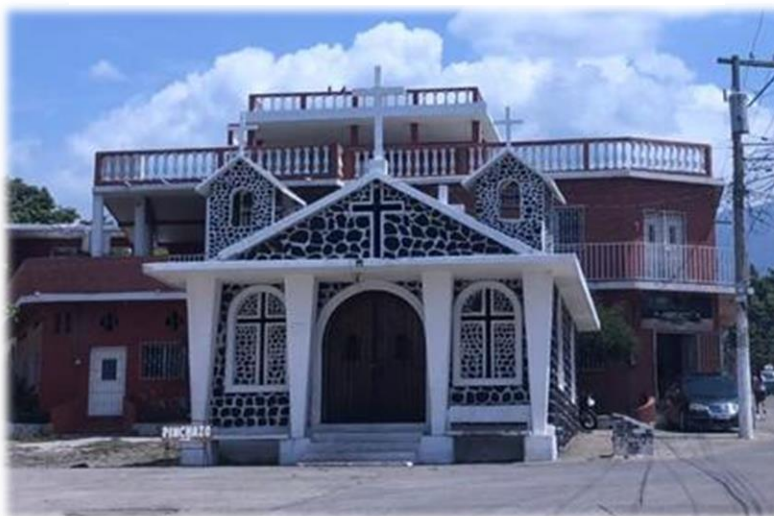
Figura 51: Fotografía de la conocida como Iglesia de Piedra en la Colonia Castillo, Taxisco. Fuente: Propia
