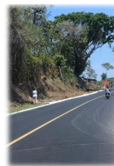
Figura 67: Ancho de carretera frente al terreno a utilizar. Fuente: Propia.
