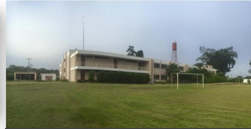
Figura 52 = Vista Instalaciones -ENCEF-. Fuente= Google Maps
