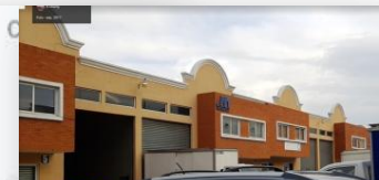
Figura 48 = Distribodogas. Fuente = Google Maps
