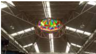
Foto No.19 Estructura Metálica, techo. Elaboración propia.
