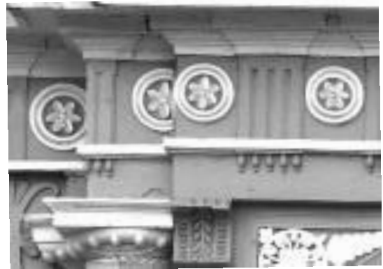
Ilustración 78 Detalle de tetraglifos en el entablamento dórico de la iglesia de San Pedro. Nótese los conflictos de modulación presentes al pasar por tres planos de fachada sucesivos. Fotografía del autor.
