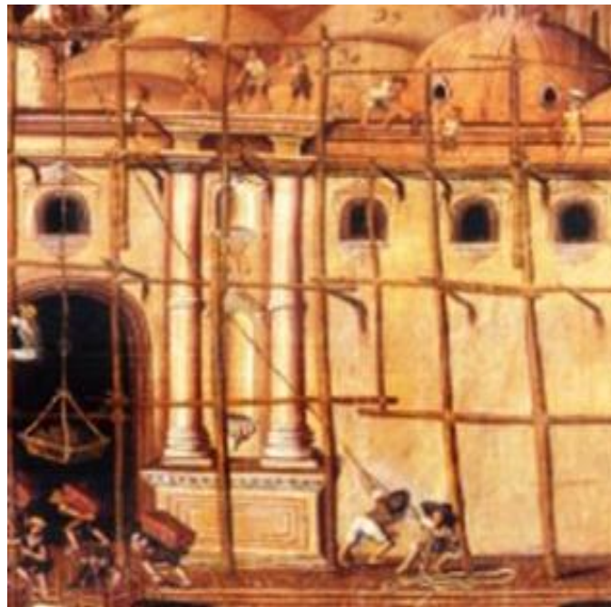
Ilustración 181 Trabajadores elevando una carga por medio de una polea de primer grado en la pintura de Antonio Ramírez de la catedral de Santiago de los Caballeros de Guatemala, 1678
