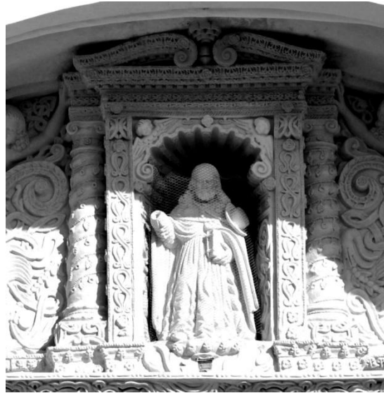
Ilustración 111 Detalle de hornacina sobre ingreso principal, obsérvese el uso de columnas salomónicas enrolladas con la Vid. Fotografía del autor, 2012
