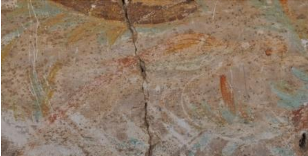
Ilustración 142 Ave, encontrada luego de limpieza con pincel, sobre puerta lateral (sur), Templo de Santa Teresa, Elaboración propia
