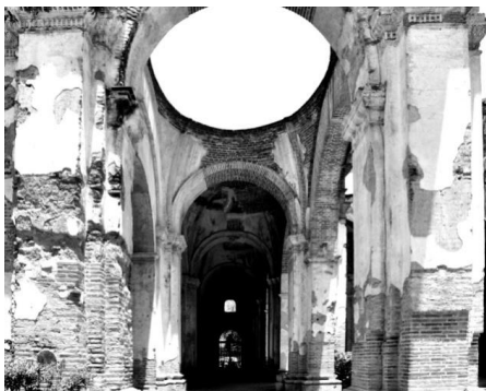
Ilustración 95 Nave lateral, nótese el pronunciado alargamiento de las bóvedas, fotografía del autor, 2010
