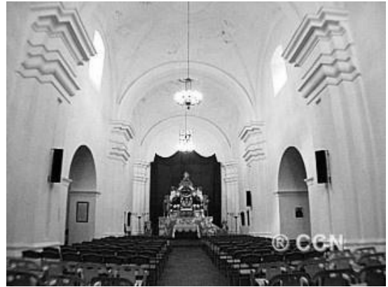
Ilustración 85 Interior iglesia Belén, nótese el detalle que utiliza Porres en el capitel y entablamento, concentrado en las pilastras. 210
