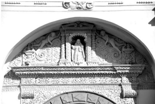
Ilustración 110 Detalle ataurique sobre ingreso principal catedral de Santiago, fotografía del autor, 2012
