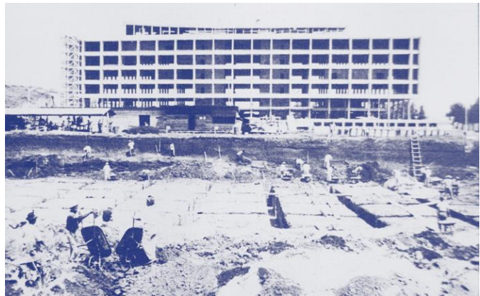
Figura 16. Construcción de la Municipalidad de Guatemala y cimentación del edificio del IGSS. Año desconocido http://rutahistorica.muniguate.com/ruta_de_ilustracion/centro_civico.html . Consultada 24 de agosto de 2019 16:20h
