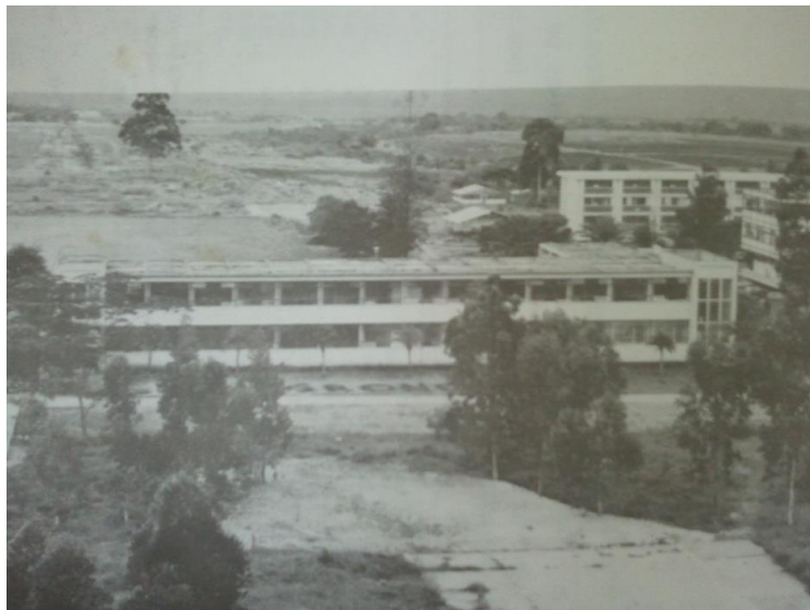
Figura 24. Edificio Antigua Facultad de Agronomía. Fotografía en tesis de grado Registro y Catalogación del antiguo edificio de la Facultad de Agronomía. 2016. Consultado 2019.
