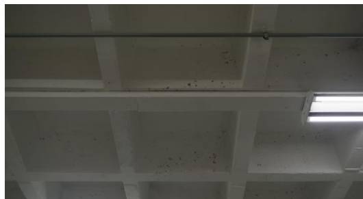
Figura 40. Vista de la losa nervada en 4to Nivel. Fotografía de Sergio Santana 2019
