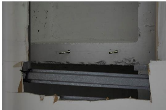
4. CONCRETO DESPRENDIMIENTO DE MATERIAL CUBIERTA
