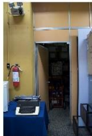
4. CONCRETO SUPERPOSICIÓN DE PINTURA COLUMNA
