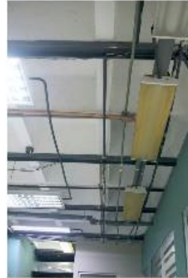
2. CONCRETO SUPERPOSICIÓN DE PINTURA CUBIERTA
