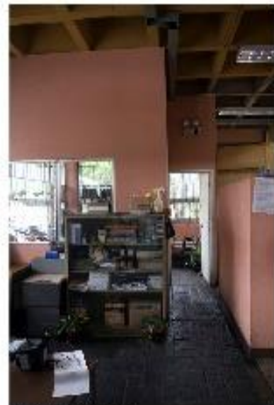
3. TABLAYESO ALTERACIÓN DE ESPACIO INTEGRACIÓN DE AMBIENTES EN PASILLO
