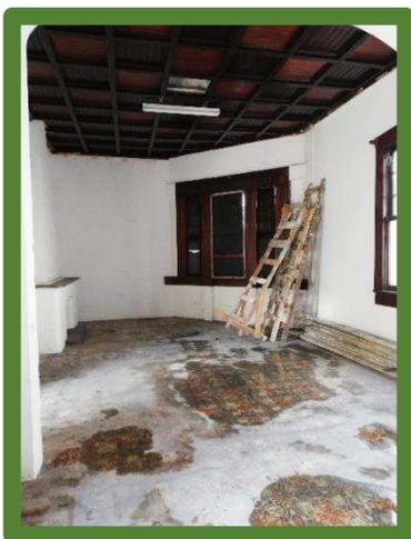
Ilustración 72: Pisos decolorados con machas y suciedad, con presencia de sales por filtración de agua.
