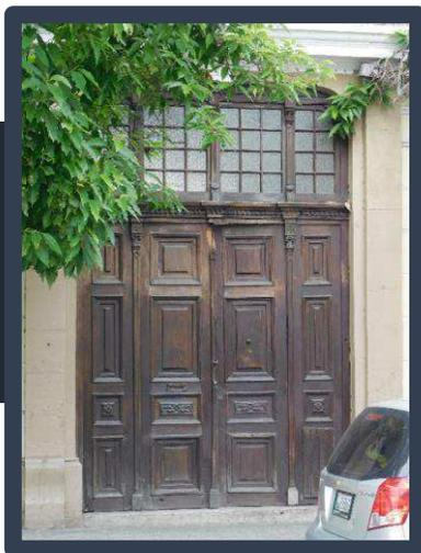
*Ilustración 35: Puerta principal de 4 cuerpos en madera más parte superior modular de madera más vidrio
