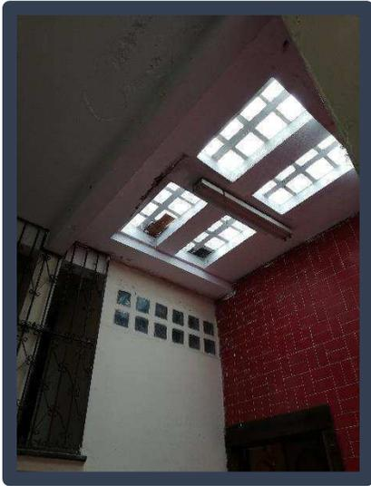
Ilustración 55: Tragaluz con block de vidrio área de pila.
