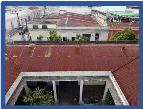
Ilustración 51: Cubierta de lámina con chimeneas de ventilación e iluminación interior.
