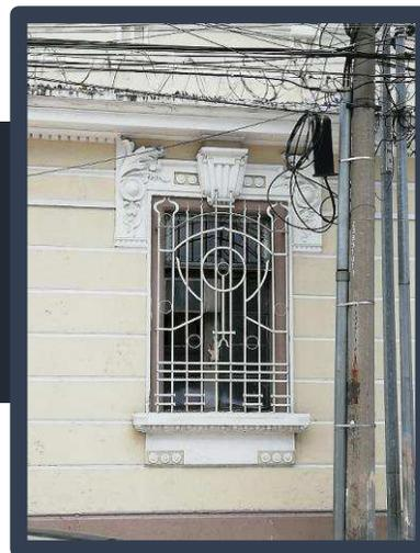
*Ilustración 36: Ventanas de madera más vidrio tipo guillotina con balcón de acero con diseño Art Nouveau.
