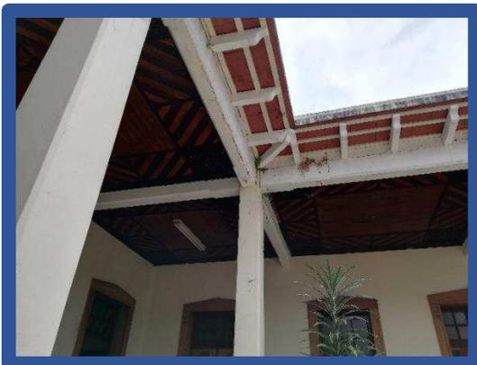
Ilustración 84: Vigas con presencia de descascaramiento y fisuras causadas por presencia de maleza.
