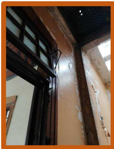
Ilustración 44: Sistema de abatimiento industrial de ventana superior.
