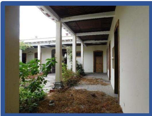
Ilustración 114: Presencia de maleza o vegetación seca en pisos de la casa lo cual causa en alguna partes el desnivel o desplome del mismo.
