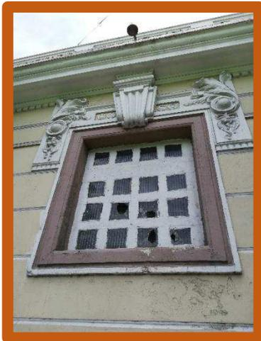
Ilustración 108: Alteración a ventana exterior causada por cambio de uso y decisión humana.
