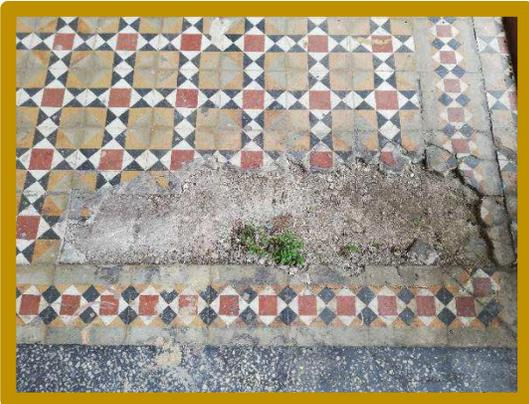
Ilustración 90: Pisos con pérdida parcial o total del material causado por falta de mantenimiento y agentes biológicos mayores como lo es la vegetación.
