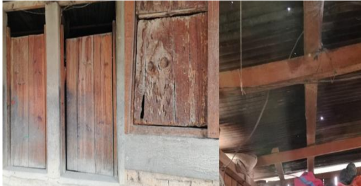
Figura 42. Puertas, ventanas y techo de la vivienda 10
