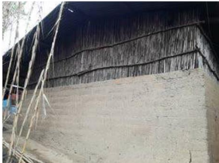
Figura 6. Vivienda con medios muros y finalizado con varillas de caña de castilla
