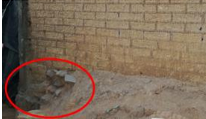
Figura 50. Parte del cimiento de la vivienda 11
