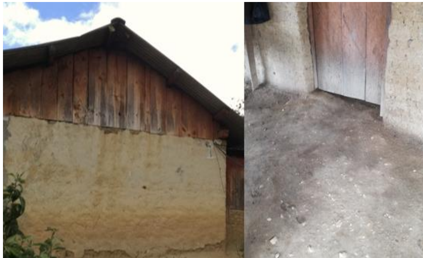
Figura 34. Piso y muros de la vivienda 8
