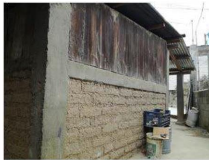
Figura 7. Vivienda con medios muros, refuerzos de concreto armado y finalizado con madera
