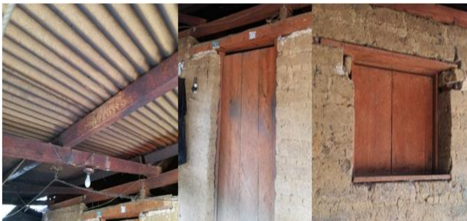
Figura 33. Puertas, ventanas y techo de la vivienda 8
