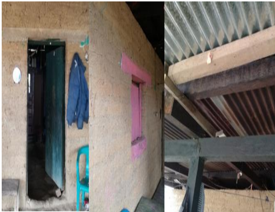
Figura 29. Puertas, ventanas y techo de la vivienda 7
