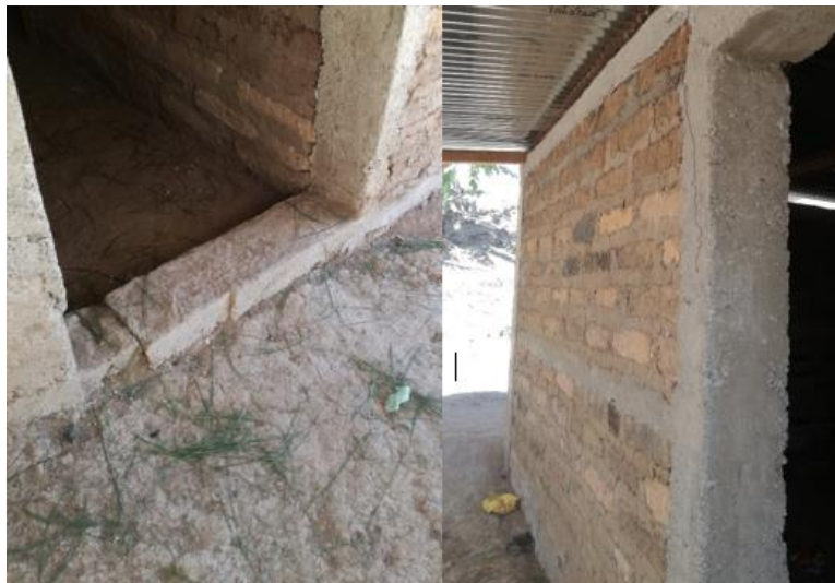
Figura 25. Piso y muros de la vivienda 6
