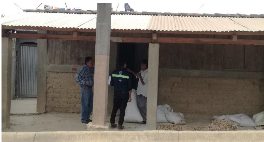
Figura 36. Vivienda 9 de adobe
