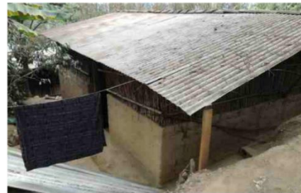
Casa de adobe con varillas de caña de Castilla en la Aldea de Cerro Alto , Municipio de San Juan Sacatepéquez, Departamento de Guatemala (Crédito: Esvin Mayor, diciembre 2017)
