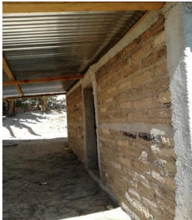
Figura 27. Refuerzos verticales y horizontales de la vivienda 6
