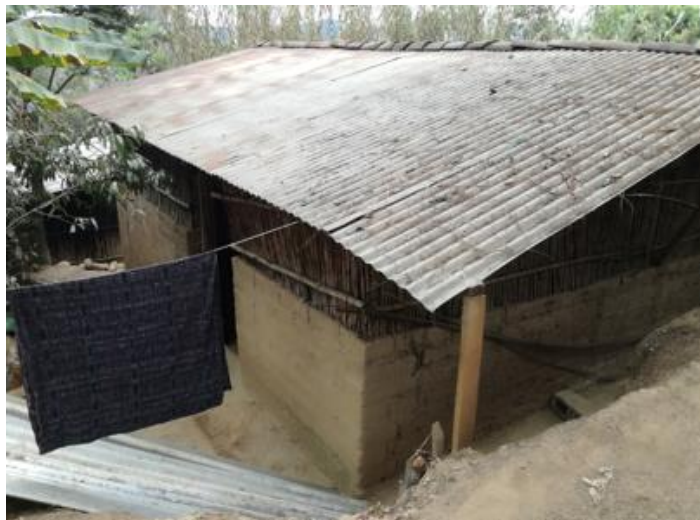
Figura 15. Vivienda 4 de adobe
