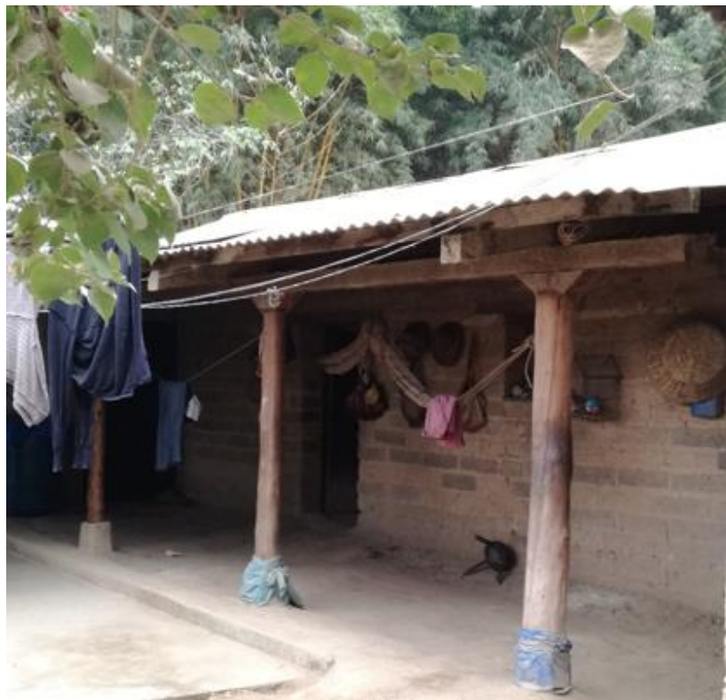
Figura 56. Vivienda 13 de adobe
