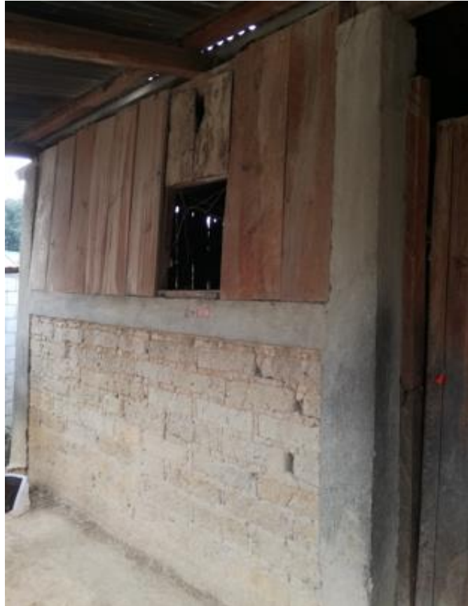
Figura 45. Refuerzos verticales y horizontales de la vivienda 10
