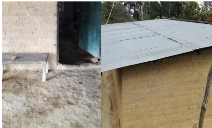
Figura 30. Piso y muros
