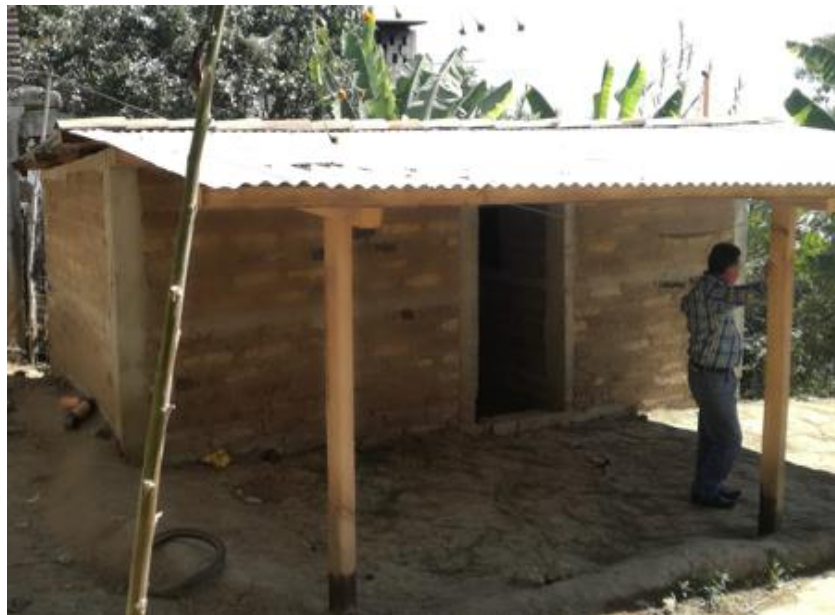
Figura 23. Vivienda 6 de adobe
