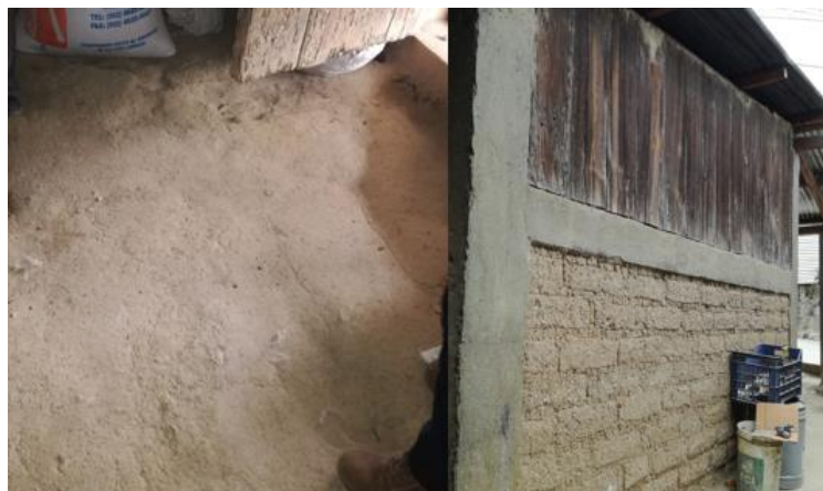
Figura 38. Piso y muros de la vivienda 9
