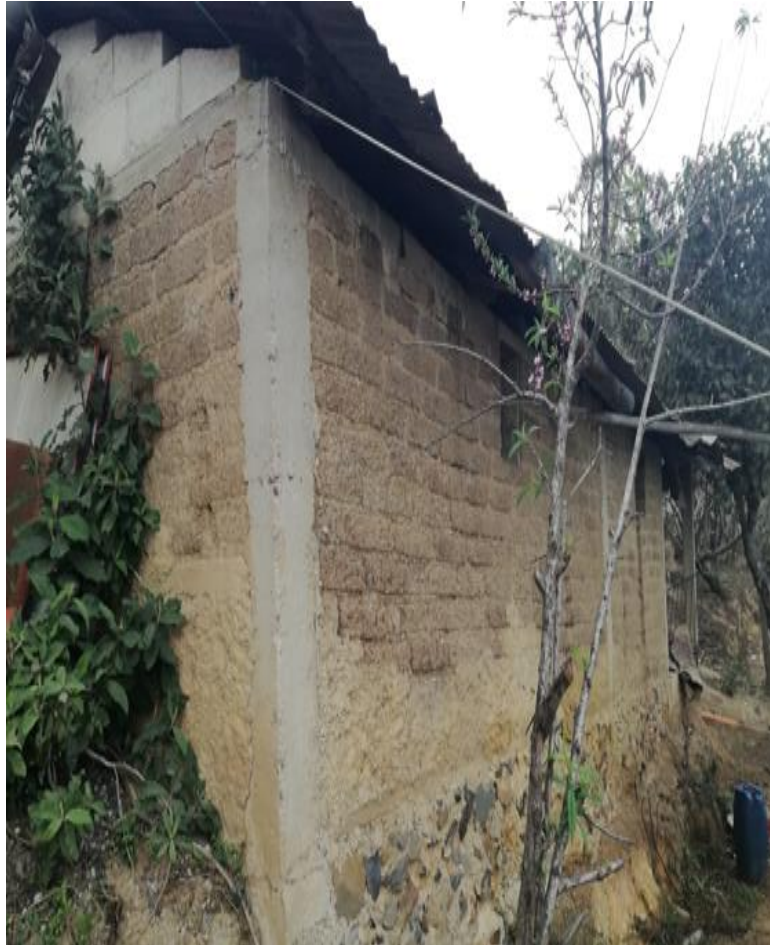
Figura 71. Refuerzos verticales y horizontales de la vivienda 15
