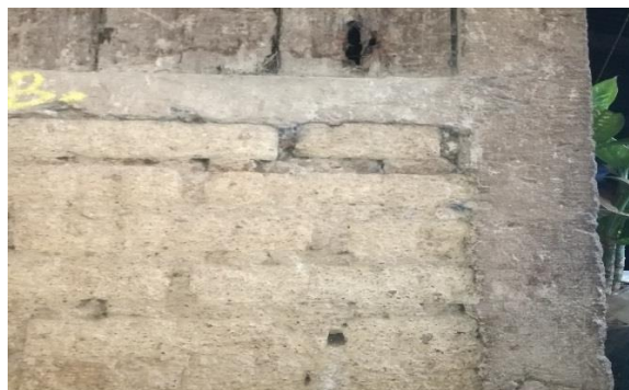
Figura 55. Refuerzos verticales y horizontales de la vivienda 12
