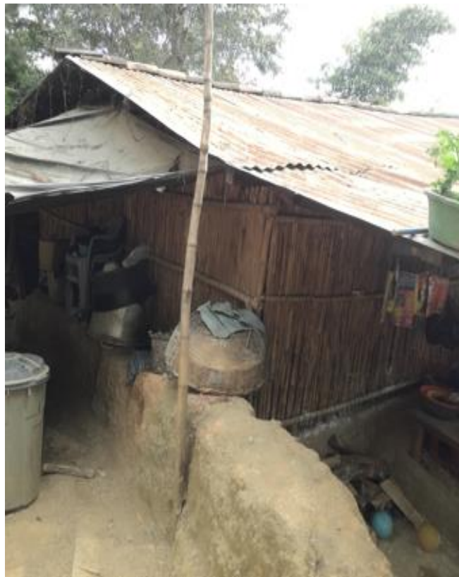
Figura 19. Vivienda 5 de adobe
