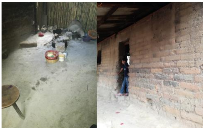
Figura 9. Piso y muros de la vivienda 2
