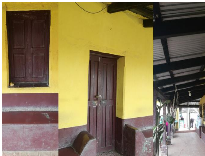
Figura 61. Puertas, ventanas y techo de la vivienda 14
