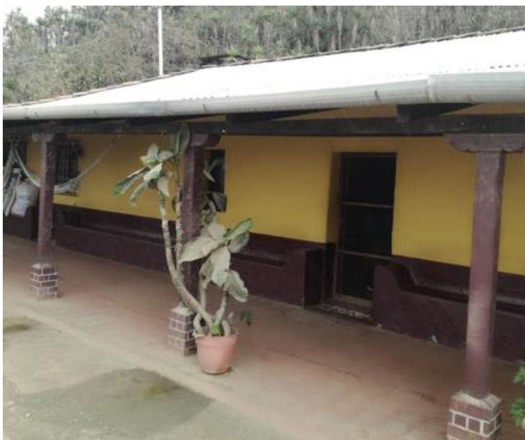
Figura 60. Vivienda 14 de adobe
