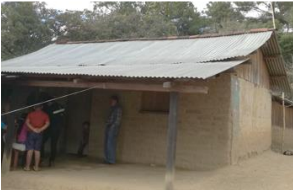
Figura 32. Vivienda 8 de adobe
