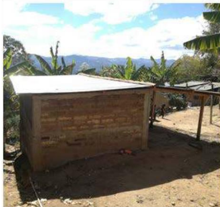
Figura 5. Viviendas con muros con refuerzos de concreto armado
