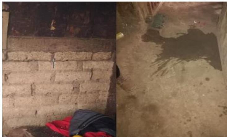
Figura 54. Piso y muros de la vivienda 12
