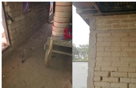
Figura 48. Piso y muros de la vivienda 11
