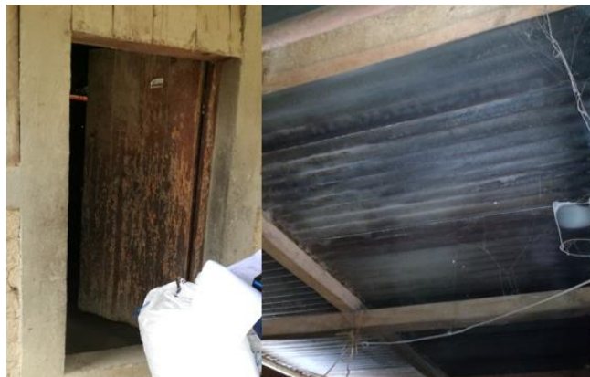
Figura 37. Puerta y techo de la vivienda 9
