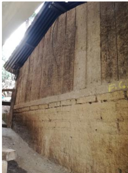
Figura 52. Vivienda 12 de adobe
