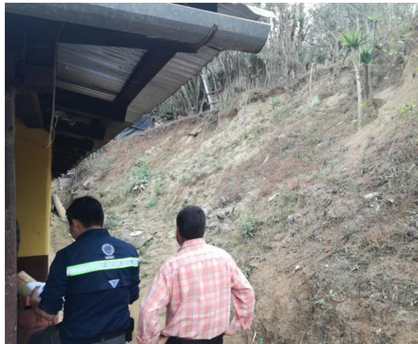
Figura 63. Talud cercano de la vivienda 14
