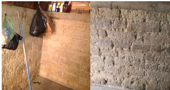
Figura 43. Piso y muros de la vivienda 10
