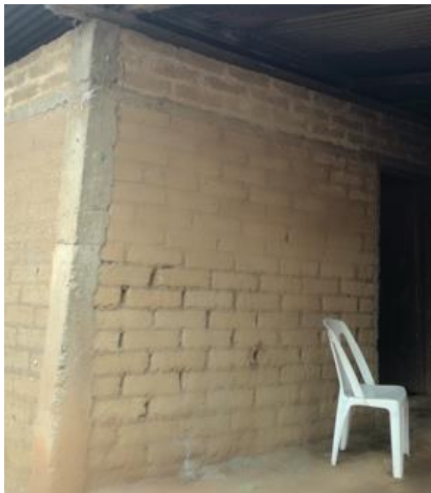
Figura 51. Refuerzos verticales y horizontales de la vivienda 11
