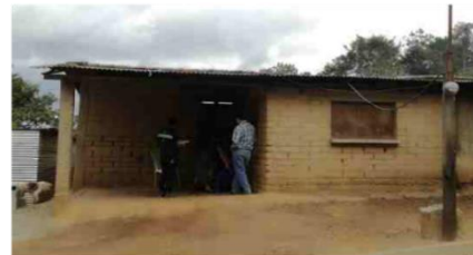
Casa de adobe con algunos refuerzos de concreto armado, en la Aldea de Cerro Alto, Municipio de San Juan Sacatepéquez, Departamento de Guatemala (Crédito: Esvin Mayor, diciembre 2017)
