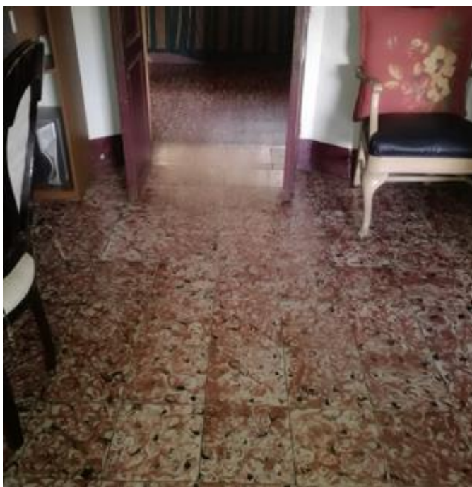
Figura 62. Piso y muros de la vivienda 14
