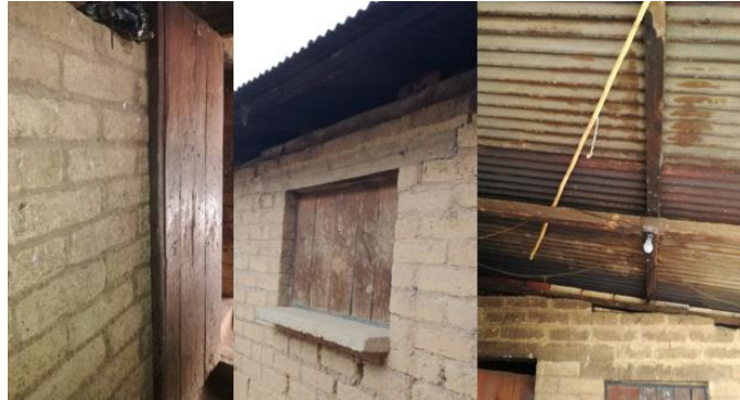
Figura 47. Puertas, ventanas y techo de la vivienda 11
