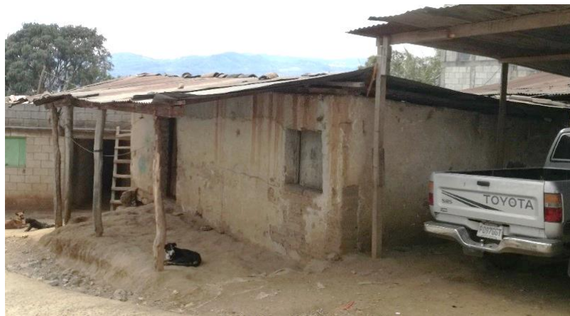
Figura 2. Vivienda 1 de adobe
