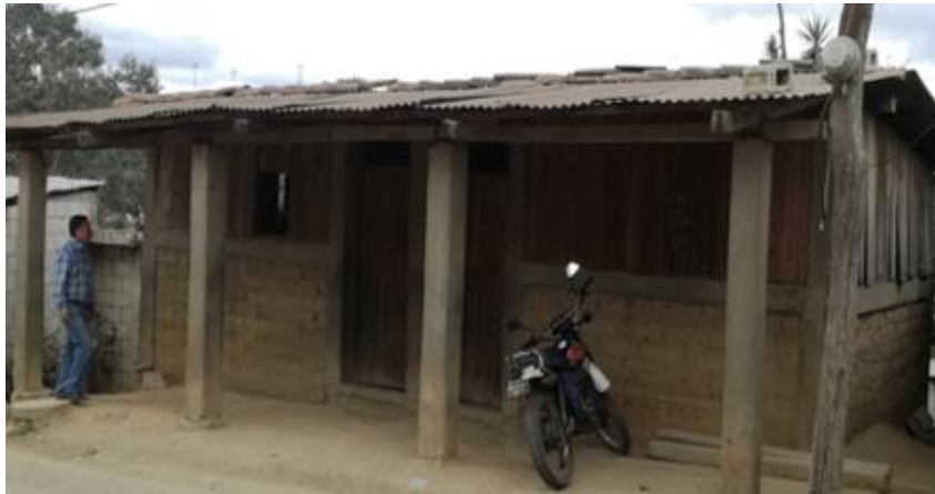
Figura 41. Vivienda 10 de adobe
