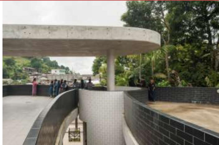
Figura 28, vista de la escuela https://www.plataformaarquitectura.cl
