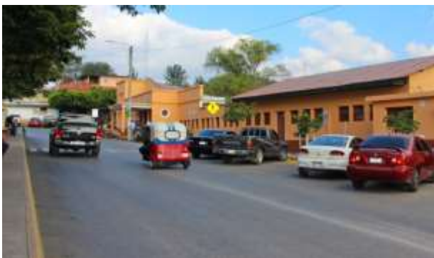
Figura 19, Vista de la Fachada Principal desde la Calle Real http://www.facebook.com/MuniPalenciaGT/
