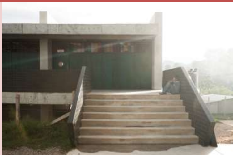
Figura 32, Vista de la Fachada Principal https://www.plataformaarquitectura.cl
