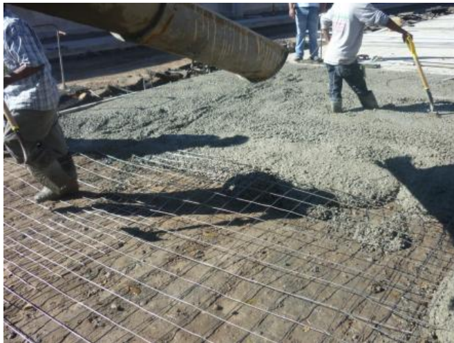
Figura 13. Preparación inicial para la capa primaria
