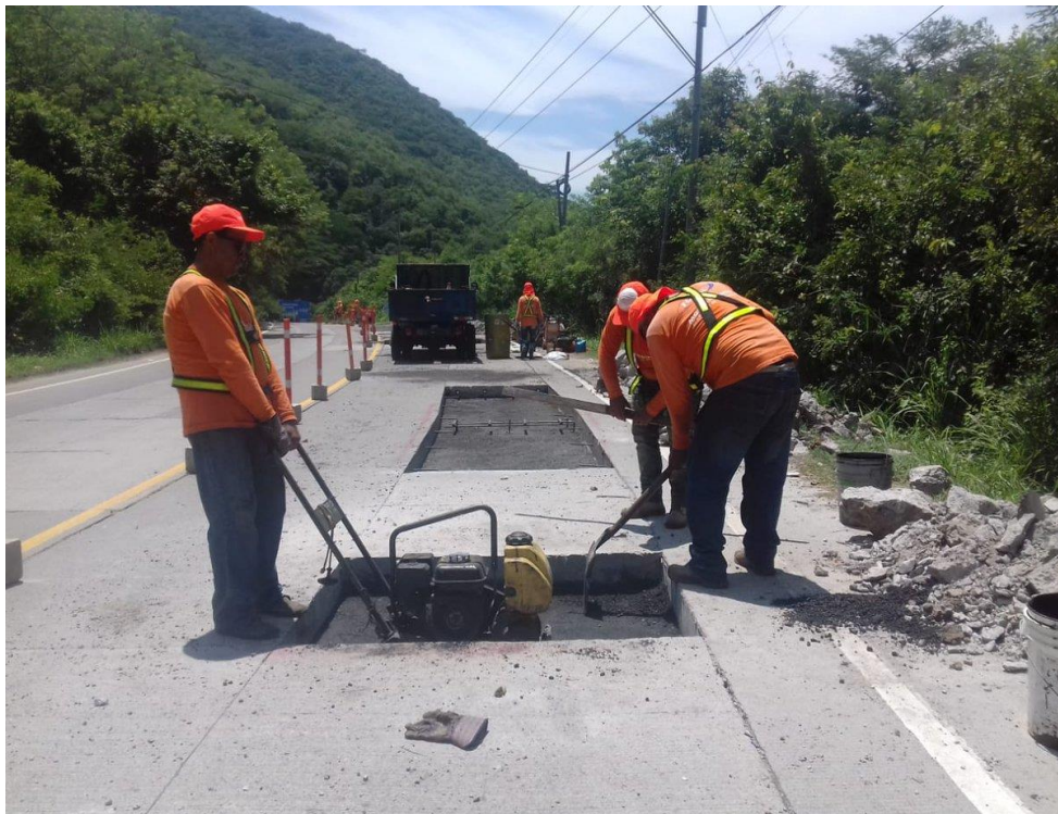
Figura 22. Reparación de losa
