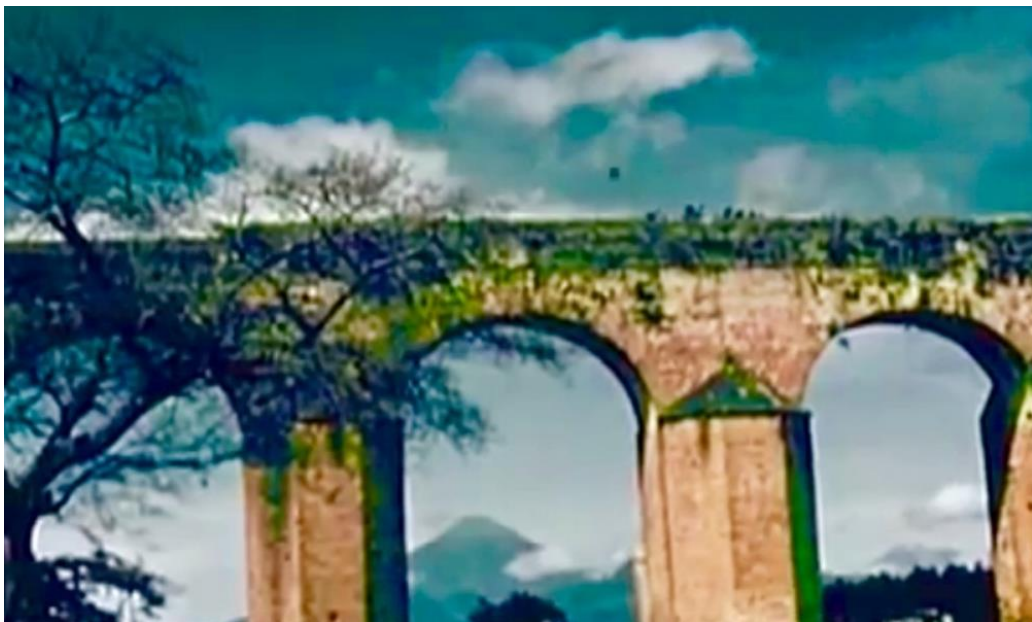
Figura 5. Acueducto de Pínula, surtió de agua la nueva Guatemala de la Asunción entre 1774 y 1938
