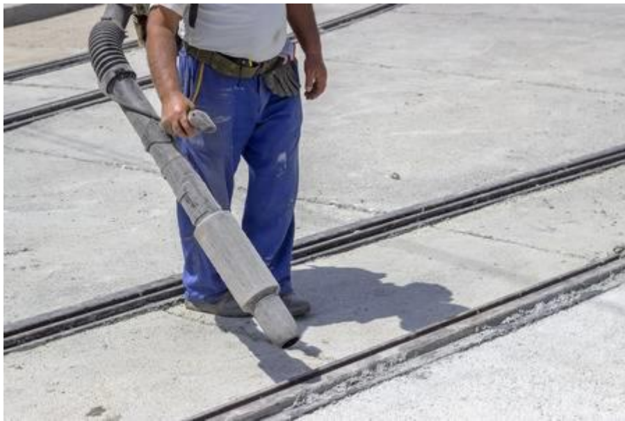
Figura 21. Soplador de asfalto para juntas recién selladas
