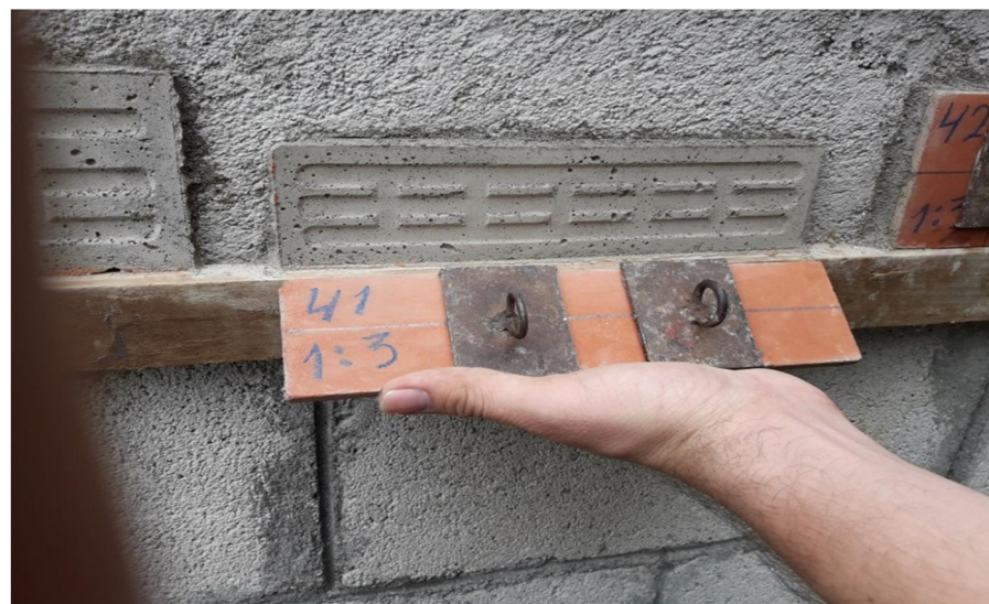
Figura 69. Falla adhesiva entre la interfaz del adhesivo y la fachaleta, mortero 4 (falla B)
