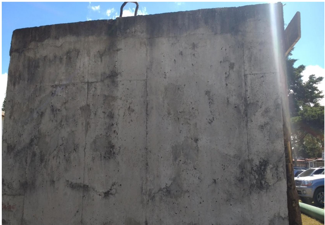
Figura 47. Superficie 5, concreto liso
