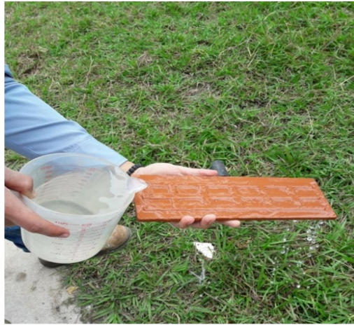
Figura 39. Humectación de fachaleta
