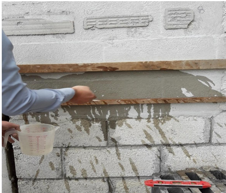
Figura 38. Limpieza y humectación de superficie
