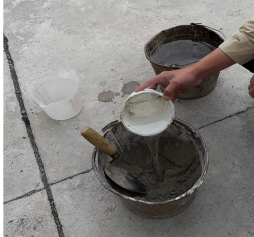
Figura 36. Mezcla de cemento, arena y agua
