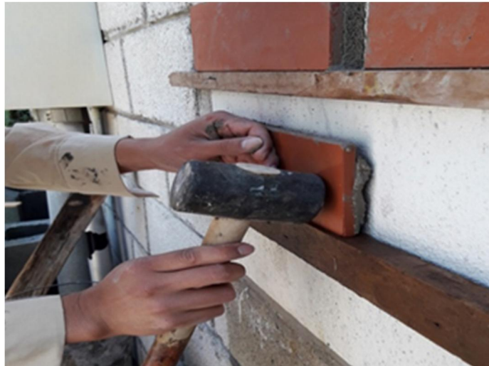
Figura 41. Instalación de fachaleta
