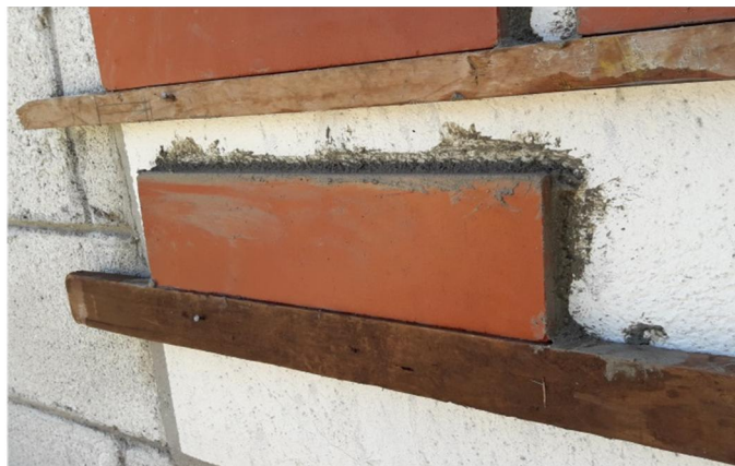
Figura 42. Fachaleta instalada
