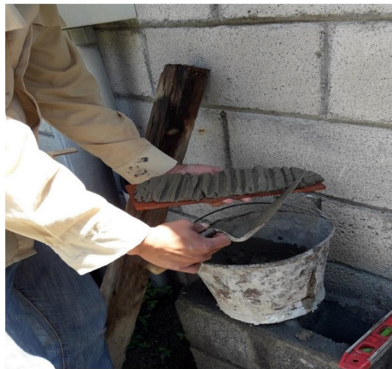
Figura 40. Distribución de mortero sobre la fachaleta
