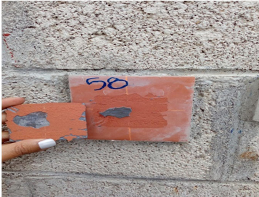
Figura 58. Falla cohesiva en el elemento ceramico, mortero 2 (falla E)
