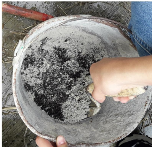
Figura 35. Mezcla de cemento y arena
