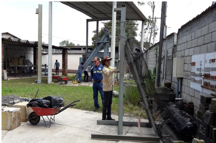
Figura 56. Ubicación y preparación del equipo para el ensayo de adherencia
