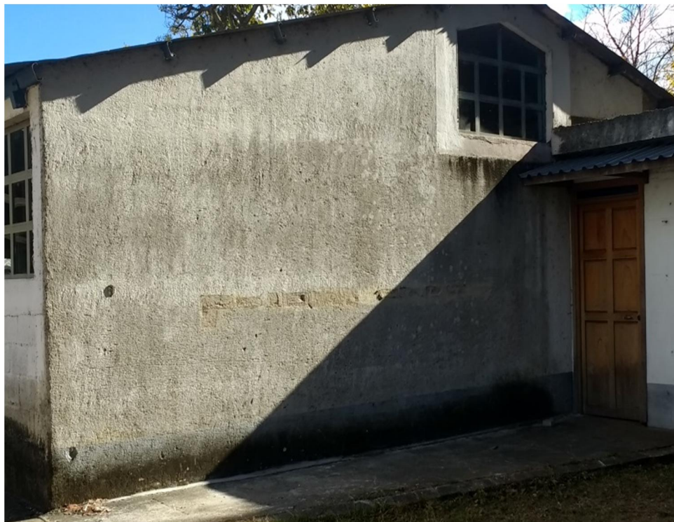
Figura 49. Superficie 7, lechada de cemento y arena
