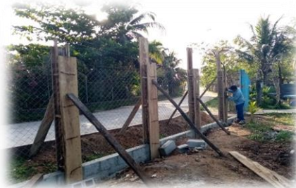
Imagen 20 y 21. Encofrado y fundición de columnas, Cerco Perimetral Frontal de la Escuela Oficial Rural Mixta Barrio Campo Amor La Pista
