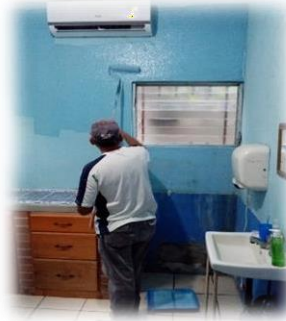
Imagen 31 y 32. Repellado y pintado de la pared interna de la clínica dental del Centro de Atención Integral Materno Infantil-CAIMI-Centro de Salud, Livingston, Izabal.
