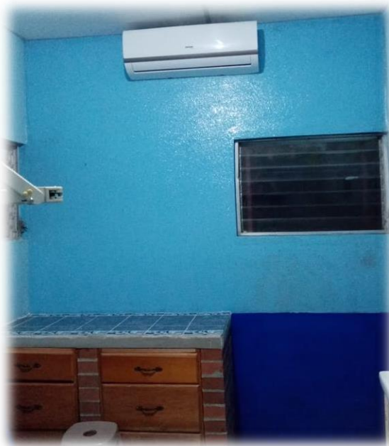
Imagen 2. Instalación de Aire Acondicionado Mini Split INNOVAIR de 12,000 BTU. Repellado y pintado de pared interna del Consultorio Dental del CAIMI-Centro de Salud.
