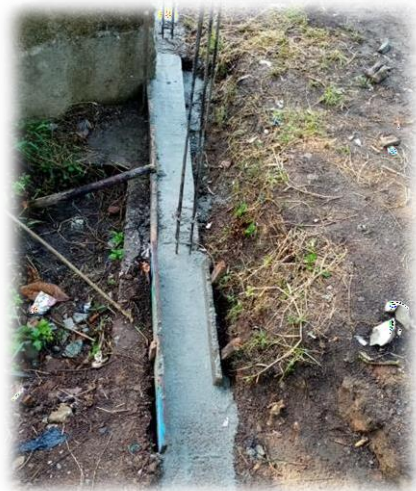
Imagen 14 y 15. Armado y fundición de cimiento corrido Cerco Perimetral Frontal de la Escuela Oficial Rural Mixta Barrio Campo Amor La Pista
