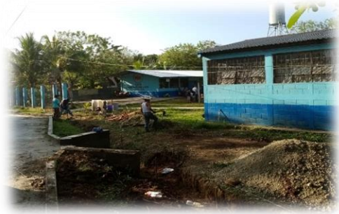
Imagen 10 y 11. Trazo, zanjeó y excavación Cerco Perimetral Frontal de la Escuela Oficial Rural Mixta Barrio Campo Amor La Pista
