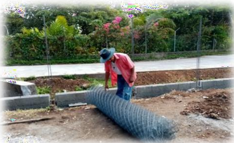
Imagen 18 y 19. Instalación de Malla Perimetral, Cerco Perimetral Frontal de la Escuela Oficial Rural Mixta Barrio Campo Amor La Pista
