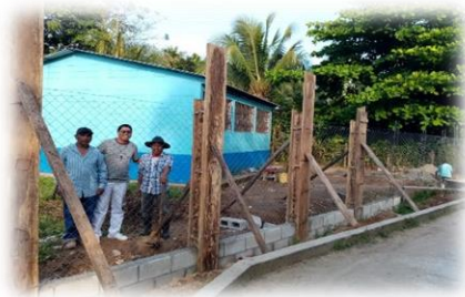
Imagen 20 y 21. Encofrado y fundición de columnas, Cerco Perimetral Frontal de la Escuela Oficial Rural Mixta Barrio Campo Amor La Pista
