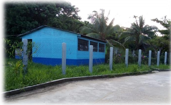
Imagen 1. Construcción de 21 metros de Cerco Perimetral Frontal de la Escuela Oficial Rural Mixta Barrio Campo Amor la Pista.
