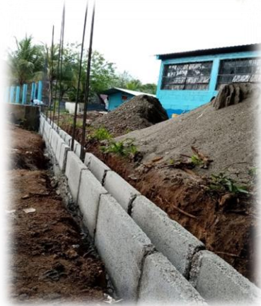
Imagen 16 y 17. Levantamiento de solera, Cerco Perimetral Frontal de la Escuela Oficial Rural Mixta Barrio Campo Amor La Pista
