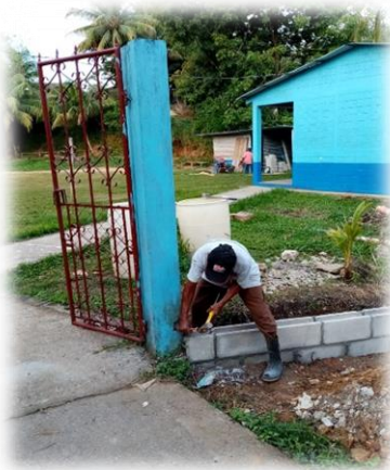
Imagen 16 y 17. Levantamiento de solera, Cerco Perimetral Frontal de la Escuela Oficial Rural Mixta Barrio Campo Amor La Pista
