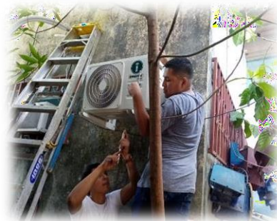
Imagen 27,28,29 y30. Secuencia de instalación del nuevo aire acondicionado en la clínica dental del Centro de Atención Integral Materno Infantil-CAIMI-Centro de Salud, Livingston, Izabal.
