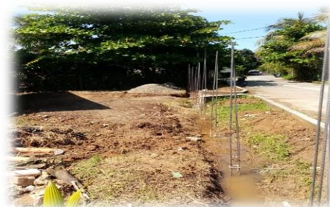
Imagen 12 y 13. Armado de Columnas Cerco Perimetral Frontal de la Escuela Oficial Rural Mixta Barrio Campo Amor La Pista
