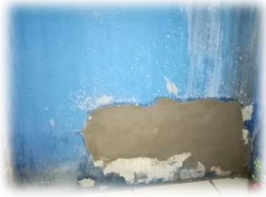
Imagen 31 y 32. Repellado y pintado de la pared interna de la clínica dental del Centro de Atención Integral Materno Infantil-CAIMI-Centro de Salud, Livingston, Izabal.
