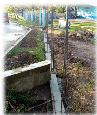
Imagen 14 y 15. Armado y fundición de cimiento corrido Cerco Perimetral Frontal de la Escuela Oficial Rural Mixta Barrio Campo Amor La Pista
