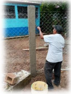
Imagen 22 y 23. Tallado de Columnas, Cerco Perimetral Frontal de la Escuela Oficial Rural Mixta Barrio Campo Amor La Pista.
