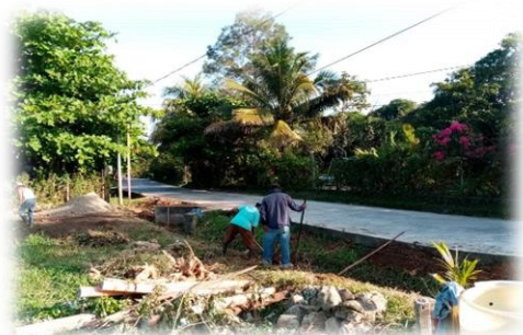
Imagen 10 y 11. Trazo, zanjeó y excavación Cerco Perimetral Frontal de la Escuela Oficial Rural Mixta Barrio Campo Amor La Pista
