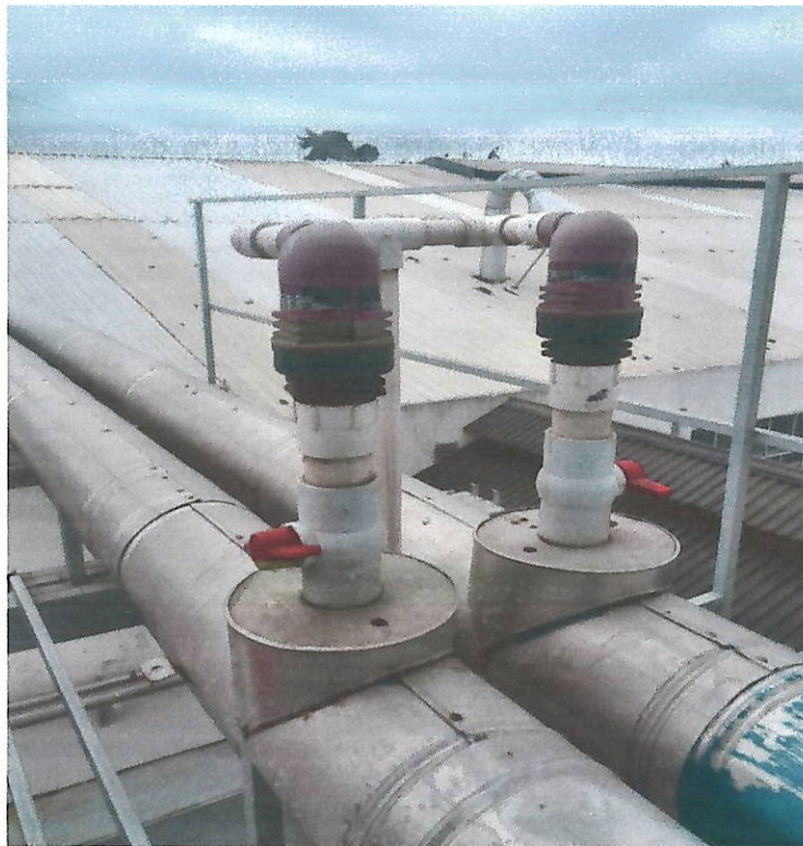
Figura 59. Válvulas de separación de aire
