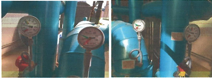
Figura 51. Presiones de bombas de circulación
