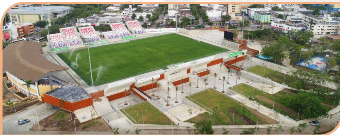
Fotografía # 12. Fachada occidental. Fuente: Plataforma Arquitectura, 2019
