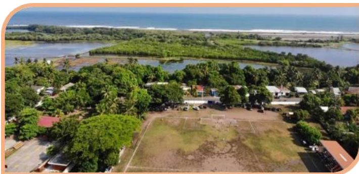
Fotografía # 97. Área de estero que ocasiona erosión. Sipacate, Escuintla. Fuente: Uziel Flores, 2019.
