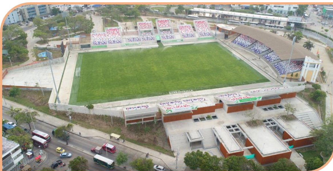
Fotografía # 13. Fachada oriental. Fuente: Plataforma Arquitectura 2019
