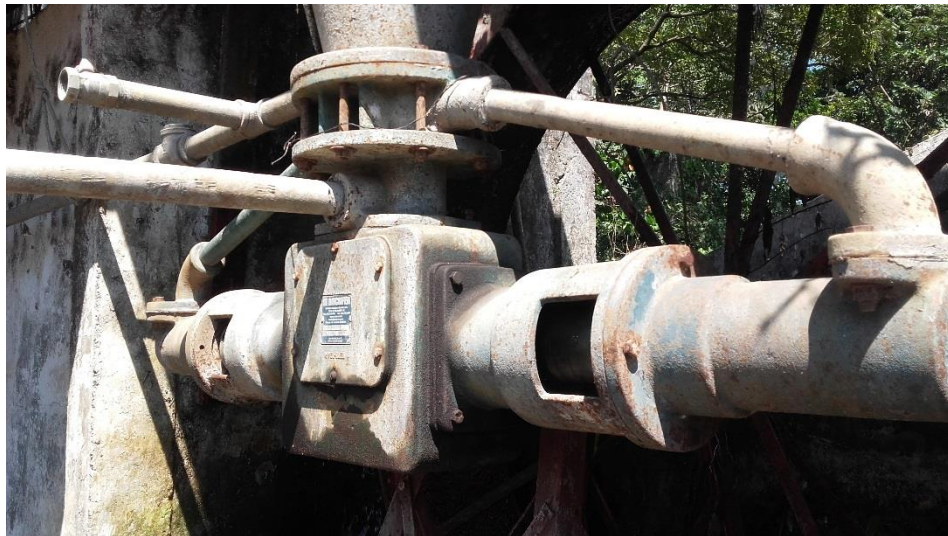
Figura 45. Fotografía bomba Rochfer MS-89 ubicada en finca Sabana Grande durante diagnóstico
