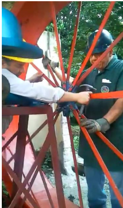
Figura 87. Montaje de la rueda de cangilones hidráulicos
