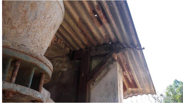
Figura 51. Techo de la estación de bombeo
