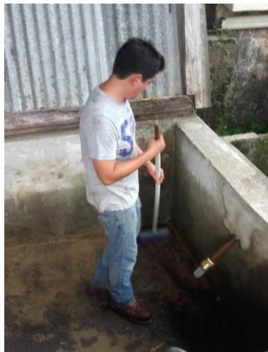
Figura 110. Limpieza de las paredes del filtro por decantación
