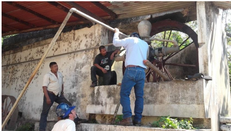
Figura 55. Tubería de succión durante el diagnóstico
