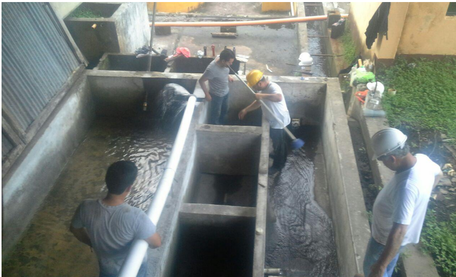
Figura 111. Fotografía del llenado de filtro por decantación
