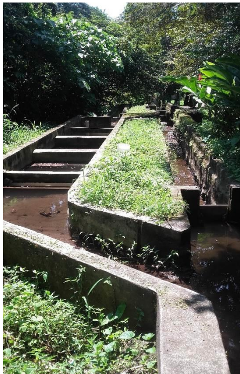
Figura 60. Módulo de filtrado por decantación salto de agua
