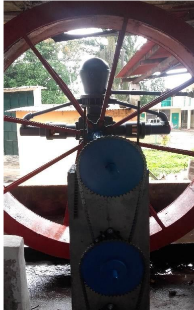
Figura 108. Bomba Rochfer MS-89 en la nueva estación de bombeo
