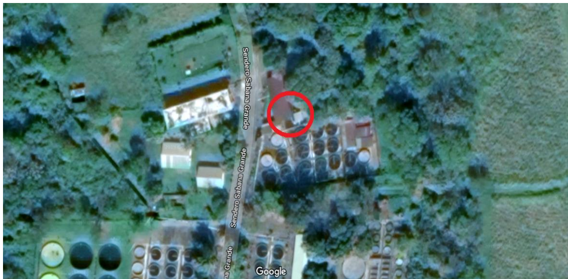
Figura 59. Fotografía satelital de la estación de bombeo de la RMS-89
