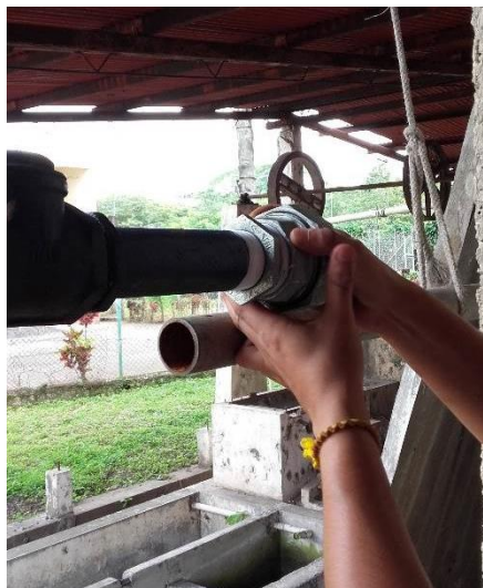
Figura 91. Instalación de uniones universales a la tubería
