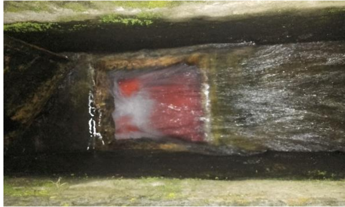
Figura 109. Canal de entrada del salto de agua
