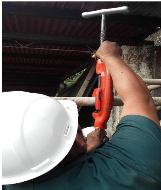
Figura 62. Desmontaje por medio de cortatubos
