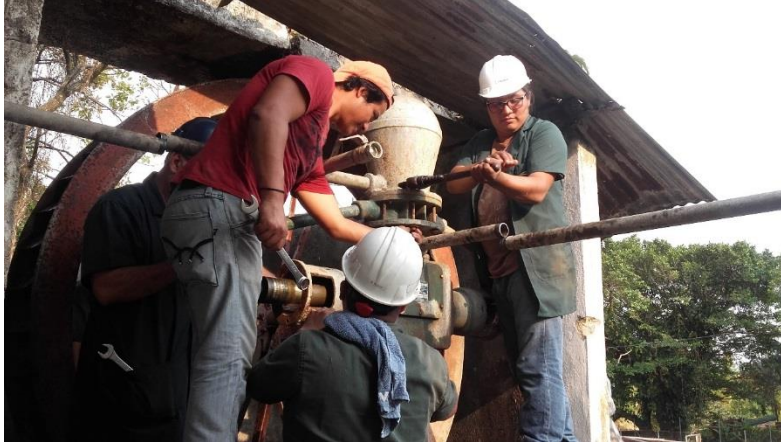
Figura 63. Desmontaje cámara estabilizadora de la bomba hidráulica
