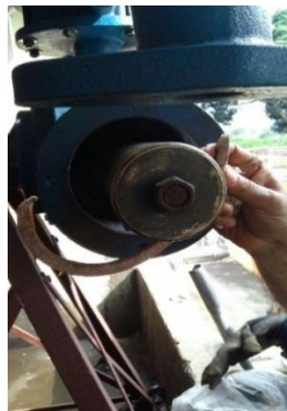
Figura 97. Posicionamiento de la estopa industrial junto al pistón
