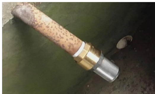
Figura 106. Instalación de pichacha en tubería de succión
