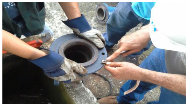
Figura 96. Corte de rodajas de estopa industrial
