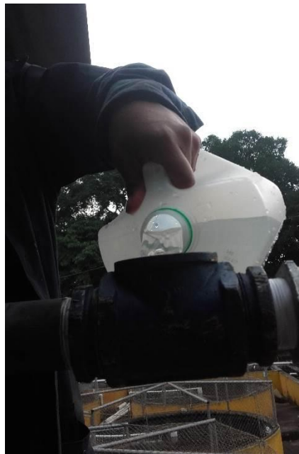
Figura 112. Cebado de tubería de succión
