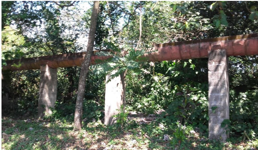
Figura 54. Canal de salto de agua
