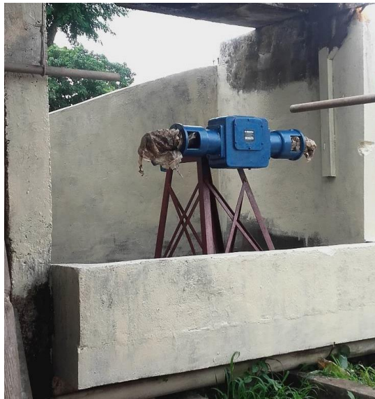
Figura 85. Estación de bombeo antes del montaje
