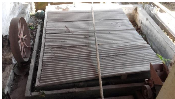
Figura 47. Sistema de filtrado por decantación
