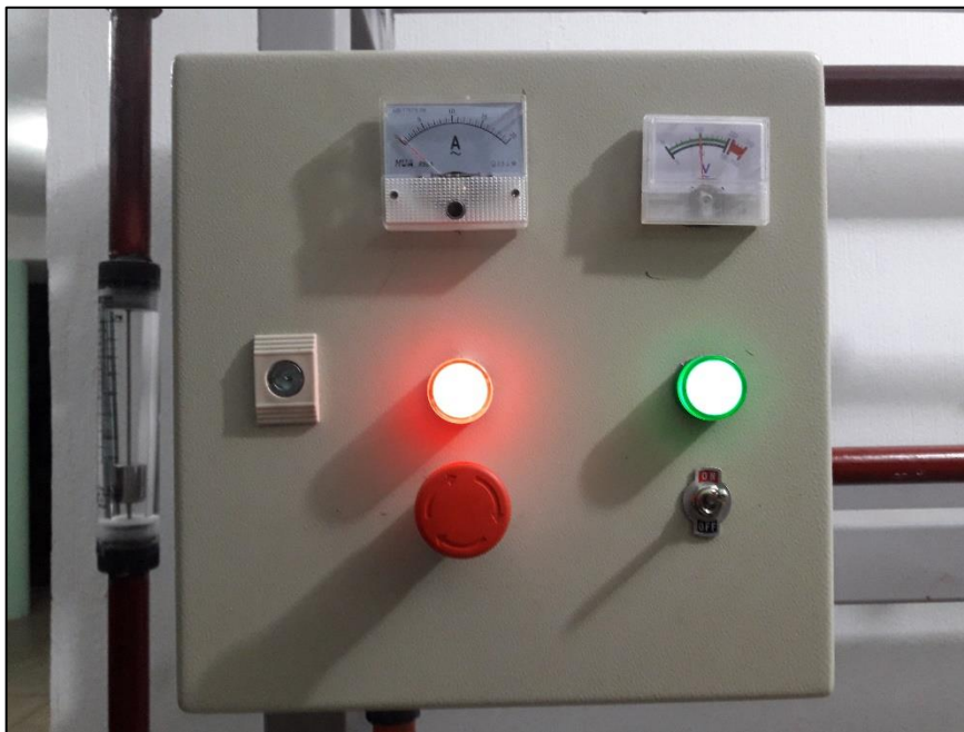
Figura 25. Prueba de encendido del equipo
