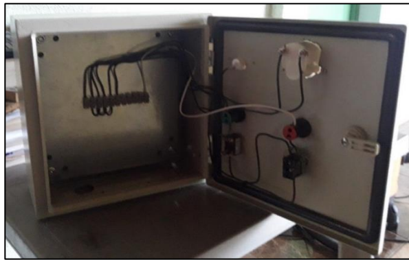
Figura 15. Armado de panel eléctrico
