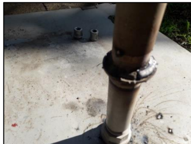
Figura 10. Soldadura de placa de orificio
