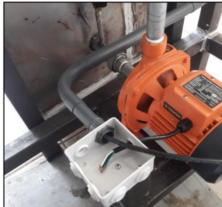
Figura 17. Instalación de cableado para bomba
