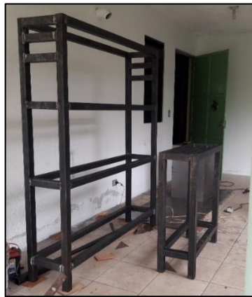
Figura 1. Soporte de la tubería en proceso de soldadura
