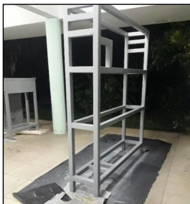
Figura 19. Aplicación de pintura a soporte de tubería
