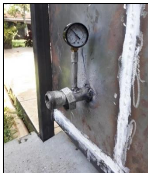
Figura 8. Soldadura de tubería de succión en tanque de almacenamiento de agua
