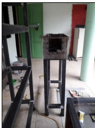
Figura 2. Soldadura de canal
