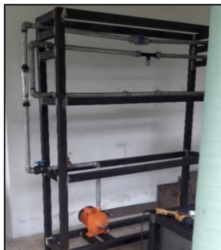
Figura 14. Montaje temporal de tubería
