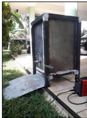
Figura 9. Tanque luego de soldadura y aplicación de sellador de juntas
