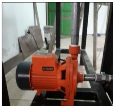
Figura 6. Montaje temporal de la bomba para determinar distancias de tuberías
