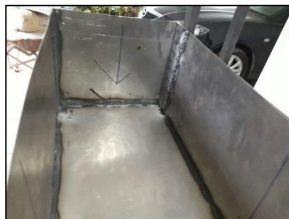
Figura 12. Soldadura de paredes internas del canal
