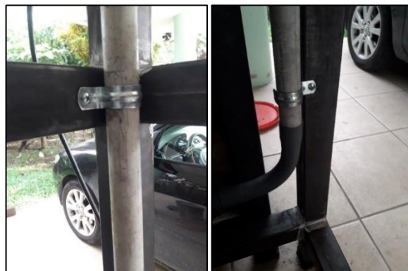
Figura 16. Colocación de ducto eléctrico
