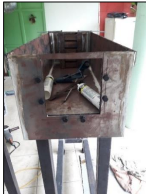
Figura 7. Canal luego de aplicación de sellador de juntas
