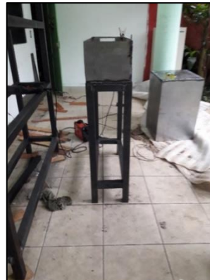
Figura 5. Canal y tanque de almacenamiento en construcción
