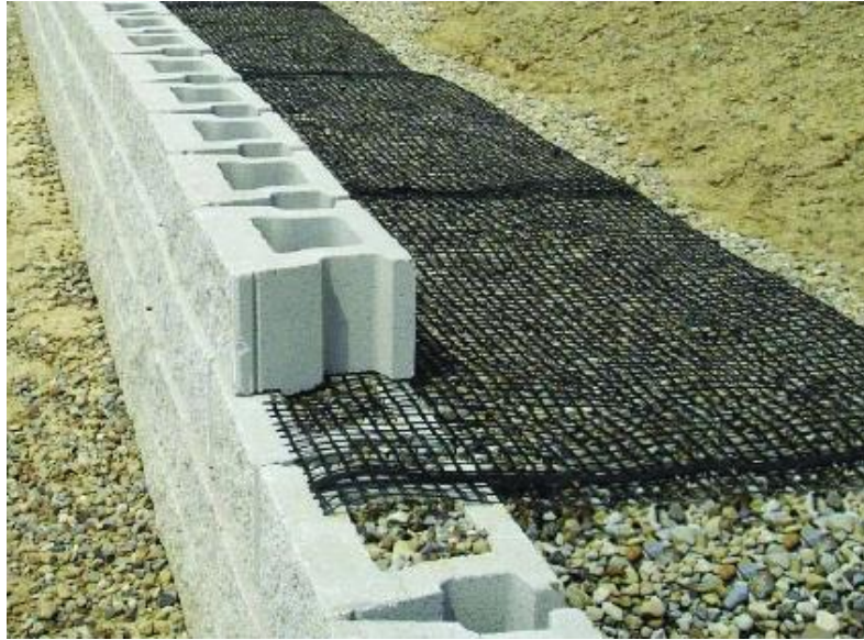
Figura 8. Conexión Interlocking
