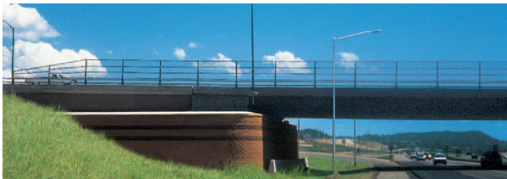
Figura 13. Estribo de puente I-25 Castle Rock, Colorado
