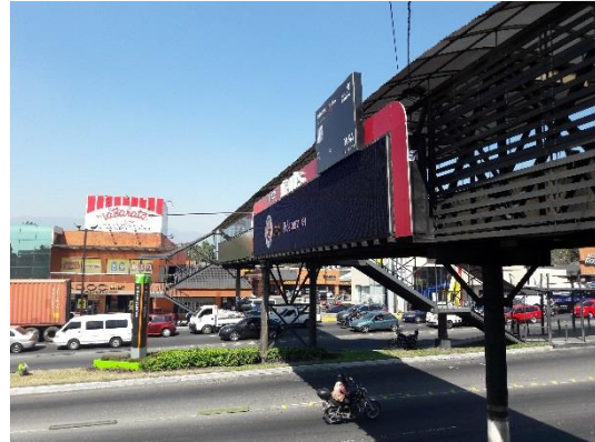
Fotografía 43: Pasarela peatonal TRANSMETRO – estación Monte María.
