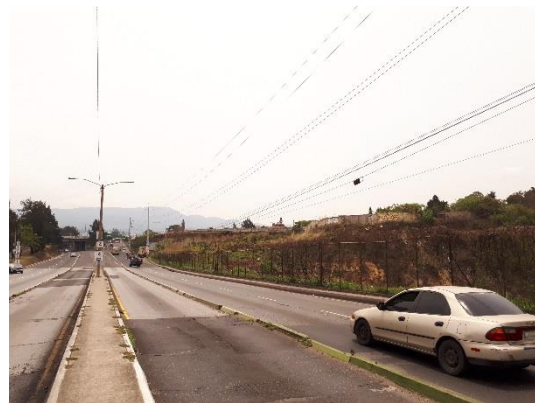
Fotografía 45: Puente Bulevar CENMA, conectividad de barranco.
