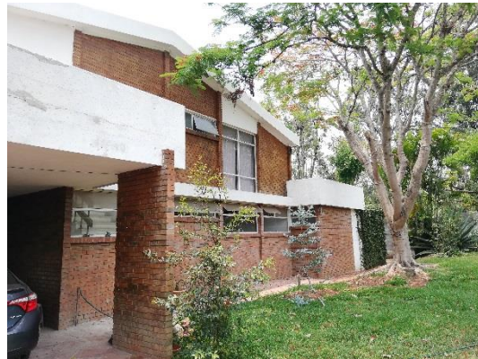
Fotografía 57: Tipología arquitectónica en la colonia Residenciales Monte María II.
