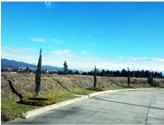
Fotografía 20: Calle s de ingreso a terrenos sin construcciones.
