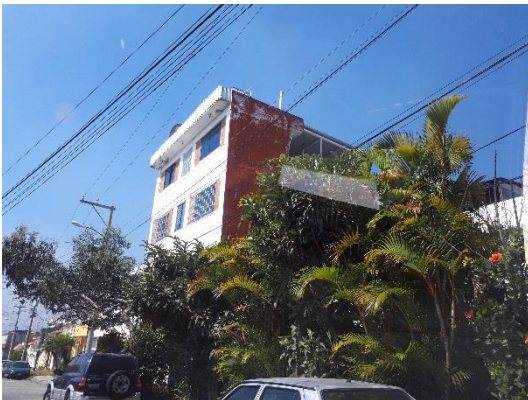
Fotografía 58: Tipología arquitectónica en la colonia Prados de Monte María.
