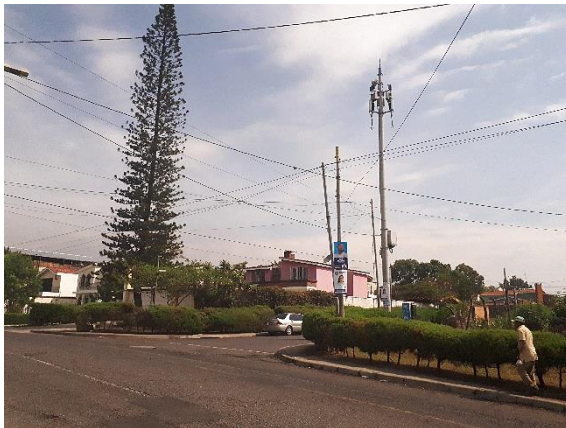
Fotografía 74: 46 Calle y 7 avenida zona 12, Monte María (c).
