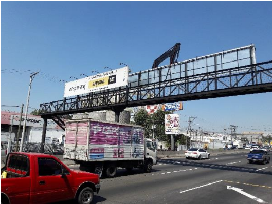
Fotografía 42: Pasarela peatonal GENTRAC- Calzada Aguilar Batres.
