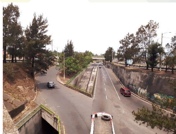
Fotografía 66: Puentes Bulevar CENMA
