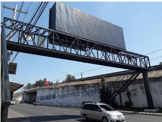
Fotografía 46: Pasarela peatonal Castañas y puente en Calzada Aguilar Batres intersección Bulevar CENMA.
