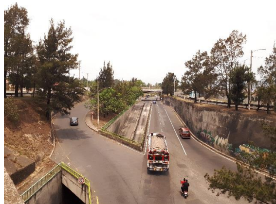
Fotografía 70: Puentes Bulevar CENMA
