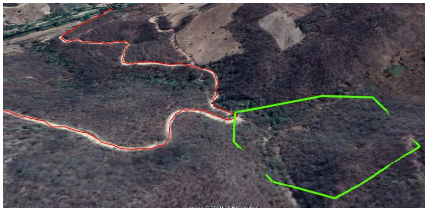
Figura 50. Área de drenado para el drenaje transversal
