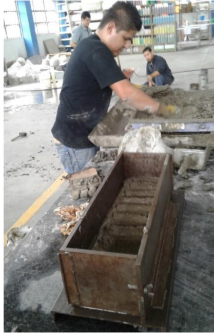
Llenado de viga con el concreto tamizado
