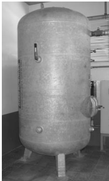
Figura 115. Tanque de almacenamiento Kaeser
