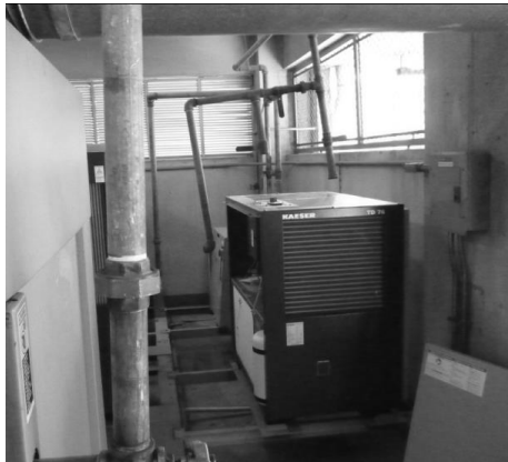
Figura 133. Instalación de tuberías de aire comprimido
