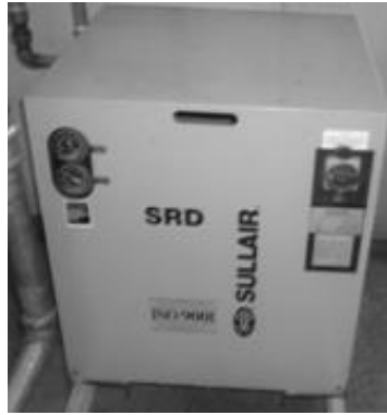
Figura 11. Secadores de aire de INHSA Molinos Modernos
