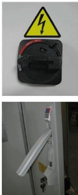
Figura 33. Dispositivos de seguridad en el armado eléctrico
