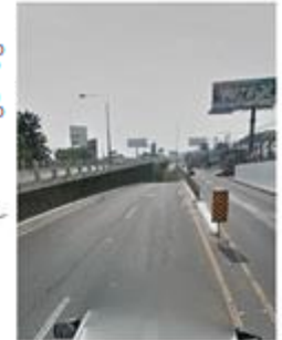
VÍA DIRECTA HACIA BULEVAR SAN CRISTÓBAL (IZQUIERDA) SIN OPORTUNIDAD DE ACCESO AL SITIO POR INTERVENIR PARA EL CENTRO DE FORMACIÓN, Y VÍA HACIA SAN LUCAS SACATEPÉQUEZ (DERECHA) AMBOS POR MEDIO DE AUTOMÓVIL O TRANSPORTE URBANO.
