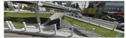
PASO A DESNIVEL CON VÍA QUE VIENE DE CIUDAD DE GUATEMALA POR CARRETERA INTERAMERICANA CA-1 HACIA VÍA BULEVAR SAN CRISTÓBAL, CON POSIBILIDAD DE ACCESO DIRECTO AL SITIO POR INTERVENIR PARA EL CENTRO DE FORMACIÓN POR MEDIO DE RETORNO VÍA BULEVAR SAN CRISTÓBAL HACIA VÍA SAN LUCAS SACATEPÉQUEZ POR CARRETERA INTERAMERICANA CA-1, Y VÍA HACIA CIUDAD DE GUATEMALA (DERECHA) POR CARRETERA INTERAMERICANA CA-1.
