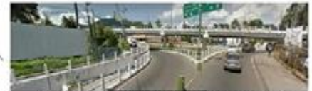
VÍA HACIA SAN LUCAS SACATEPÉQUEZ (IZQUIERDA) POR CARRETERA INTERAMERICANA CA-1, Y POSIBILIDAD DE ACCESO DIRECTO AL SITIO POR INTERVENIR PARA EL CENTRO DE FORMACIÓN POR MEDIO DE RETORNO DESDE LA CARRETERA INTERAMERICANA CA-1 Y DESVÍO CON DIRECCIÓN VÍA BULEVAR SAN CRISTÓBAL Y VÍA HACIA CIUDAD DE GUATEMALA (DERECHA) POR CARRETERA INTERAMERICANA CA-1.
