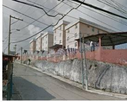
A: MODULOS DE VIVIENDA UNIFAMILIAR, LADO SUR DE SITIO POR INTERVENIR.
