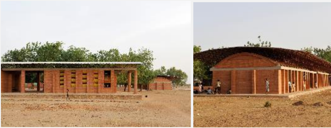
Figura 77 - Escuela Primaria de Gando. Fuente: https://www.plataformaarquitectura.cl/
