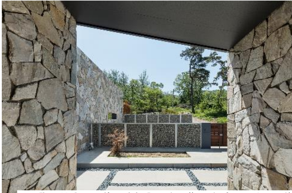
Figura 34 - Construcción en piedra. Fuente: https://www.plataformaarquitectura.cl/
