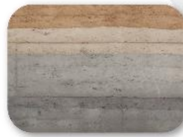
Muros de tierra y cemento compactado
