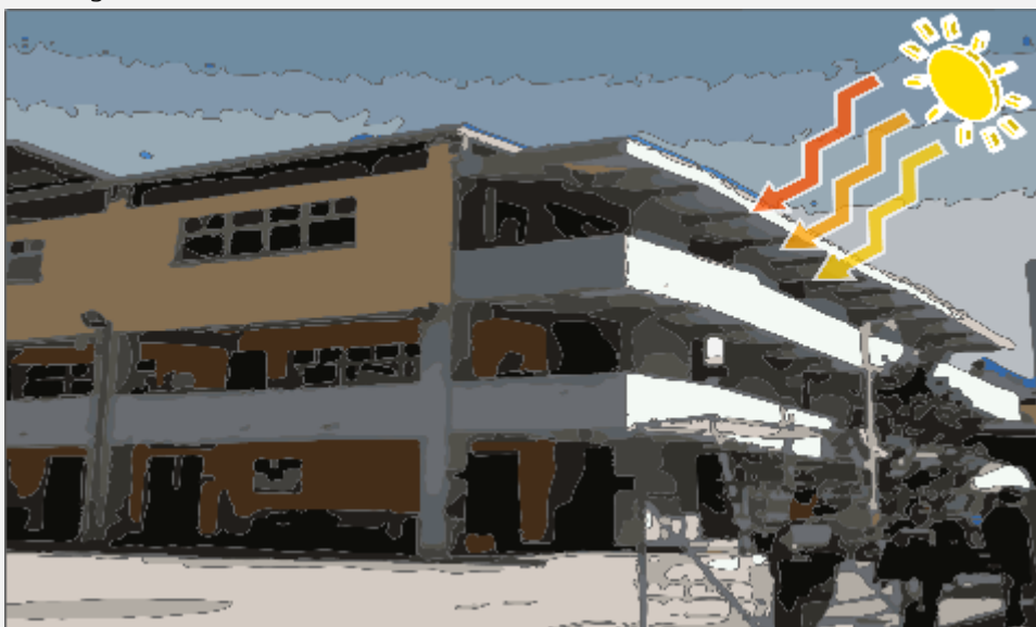
Figura 73- Voladizo y Soleamiento. Fuente: Fotografía propia.
