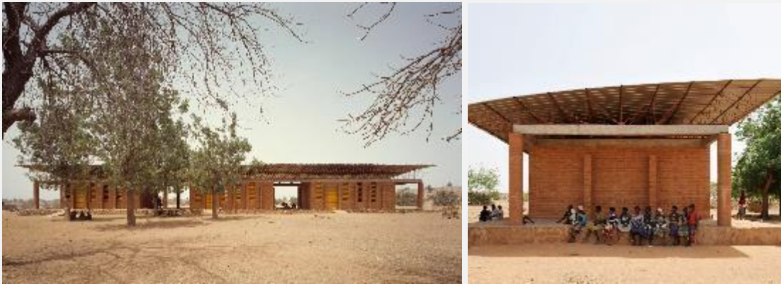
Figura 52 - Escuela Primaria en Gando. Fuente: https://www.plataformaarquitectura.cl/
