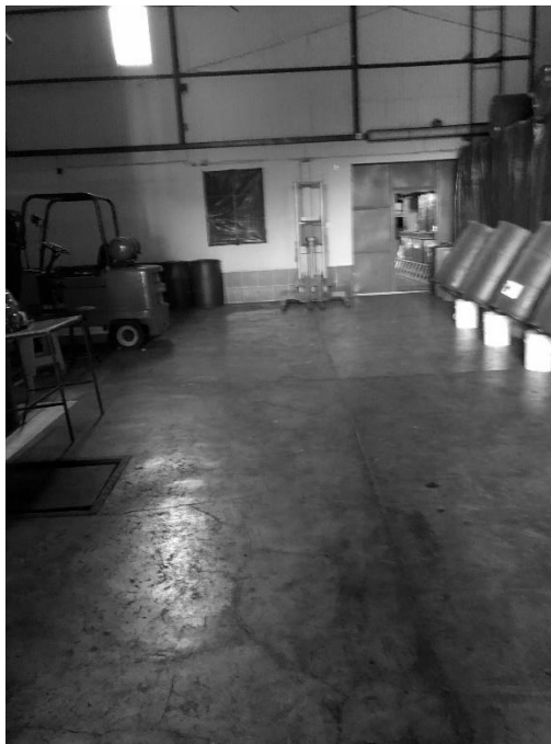
Figura 3. Piso de concreto de nave principal
