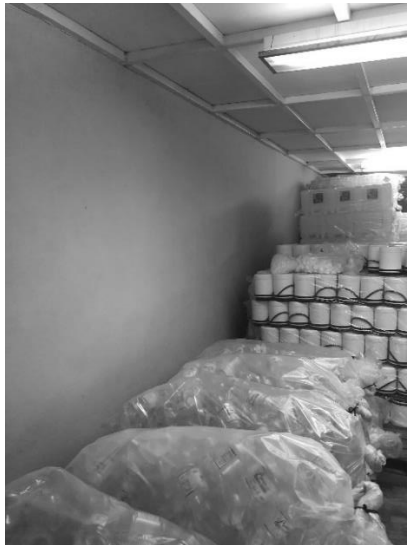
Figura 2. Techo, vigas y cubierta de área de oficinas, bodega de insumos, producto terminado y proceso
