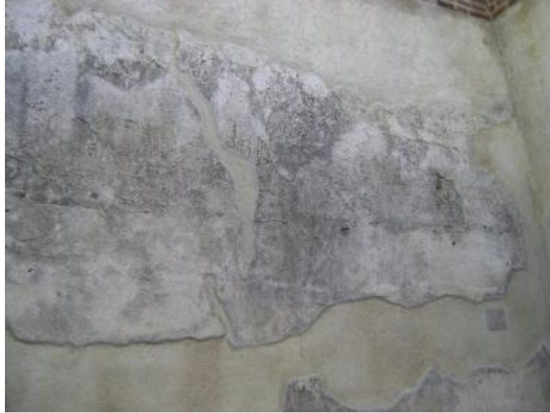
Figura 55. Falla por flexión fuera del plano de muro portante
