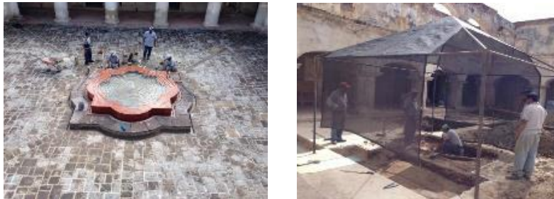
Figura 52. Trabajos de remodelación por parte del CNPAG
