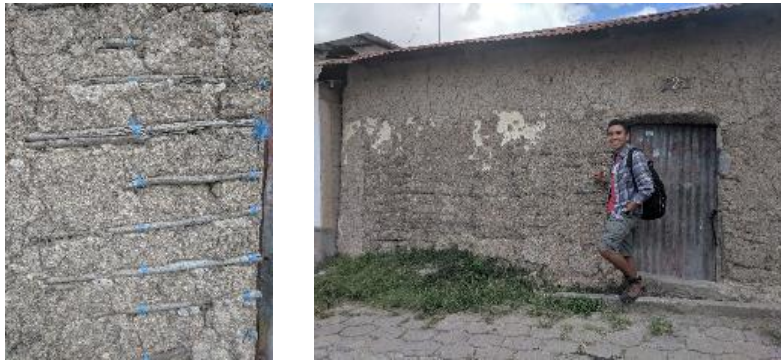
Figura 9. Casa construida con técnica de bahareque, municipio de Olopa, Chiquimula, Guatemala
