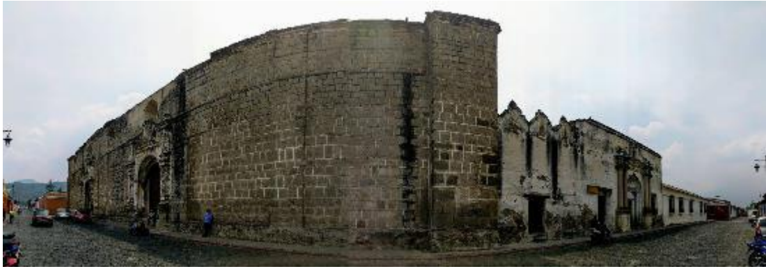
Figura 45. Vista de muro poniente del Convento Santa Clara, sobre la 2ª. Avenida Sur, La Antigua Guatemala
