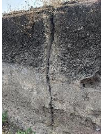
Figura 98. Ruptura transversal por flexión
