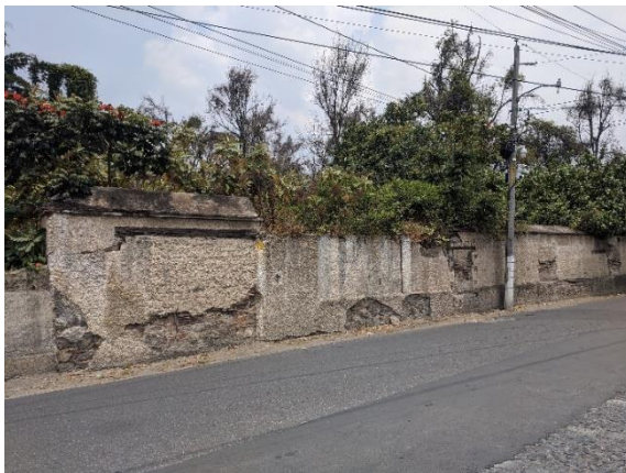
Figura 69. Deterioro en varias secciones del muro perimetral
