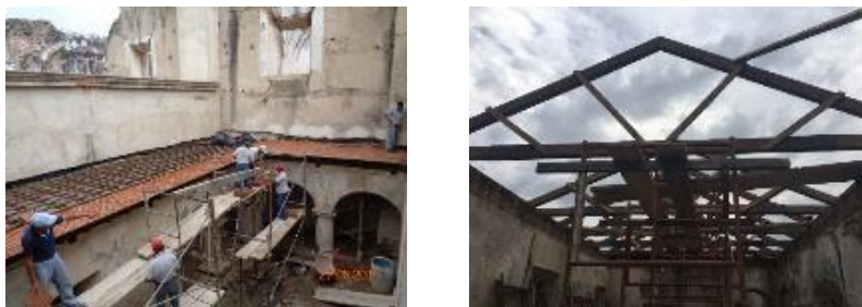
Figura 53. Trabajos en techos y entrepisos por parte del CNPAG
