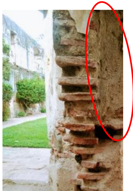
Figura 3. Mortero de cal y arena utilizado para la unir ladrillos, Ermita de San Jerónimo, La Antigua Guatemala
