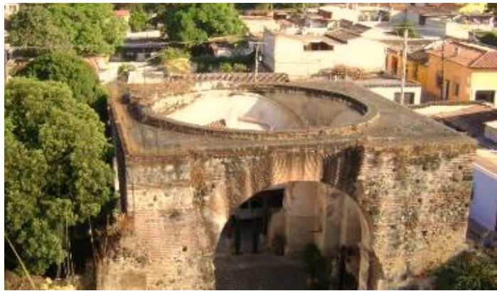
Figura 24. Vista de las pechinas de una cúpula, Templo de San Francisco El Grande
