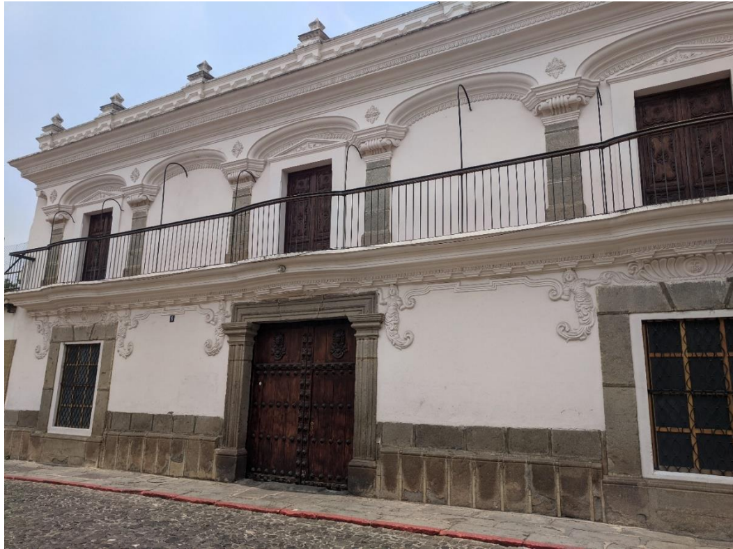
Figura 27. Vanos de puertas y ventanas construidos con roca labrada
