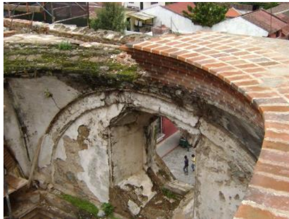
Figura 36. Borde de bóveda, área de Templo de Santa Clara
