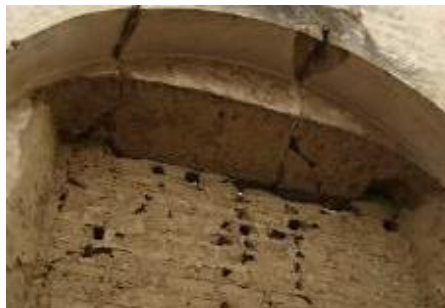
Figura 6. Pared construida con adobe, La Antigua Guatemala
