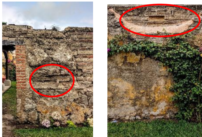
Figura 2. Paredes construidas con adobe en una casa colonial en La Antigua Guatemala
