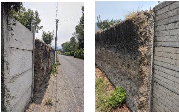
Figura 66. Muro antiguo y material contemporáneo
