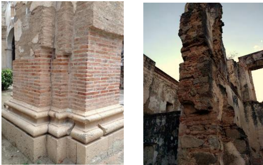
Figura 14. Materiales de construcción para columnas, San José Catedral, La Antigua Guatemala
