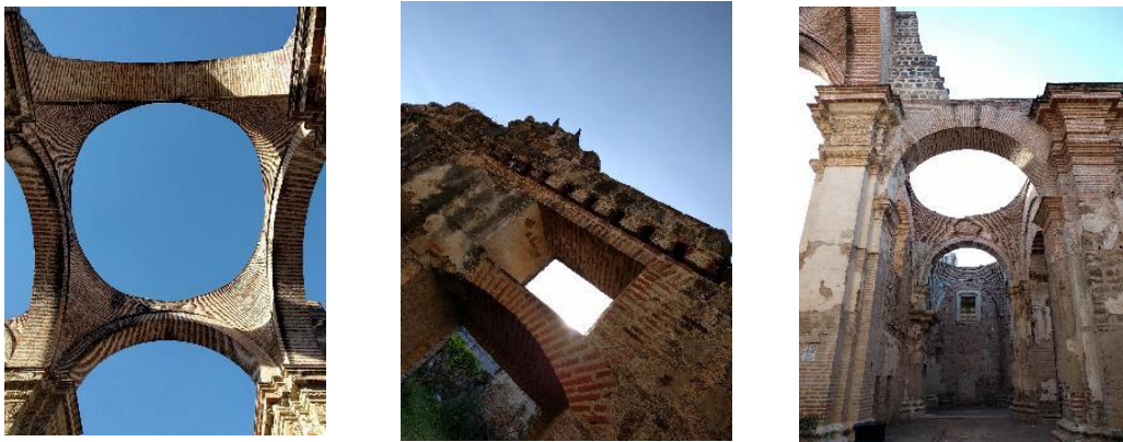
Figura 5. Diferentes elementos estructurales construidos con ladrillo, San José Catedral, La Antigua Guatemala, 2018
