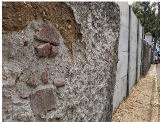
Figura 96. Materiales contemporáneos agregados al muro de tapial
