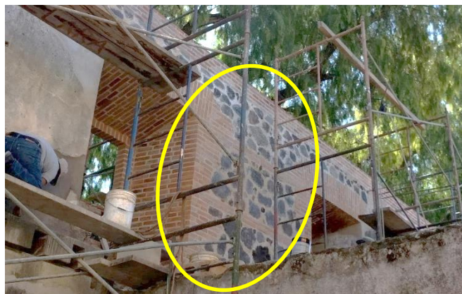
Figura 1. Calicanto entre hiladas de ladrillo
