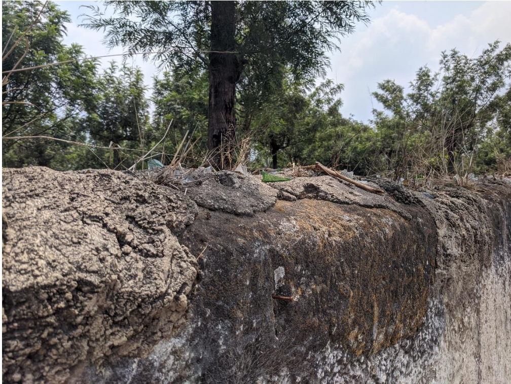
Figura 68. Vegetación encima del muro
