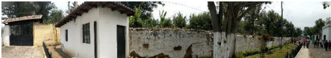
Figura 67. Panorámica del ingreso a la Finca Retana y el muro
