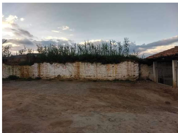
Visa 3: Muro de mampostería de probable origen colonial. Fuente: propia.
