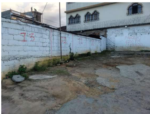
Visa 4: Edificio colindante de tres plantas. Fuente: propia.
