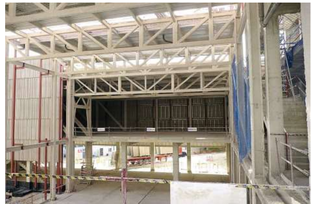
Cerchas metálicas y columnas en perfil PTR.
