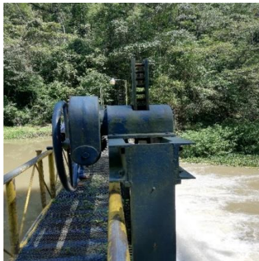
Figura 8. Mecanismo compuerta de canal de conducción
