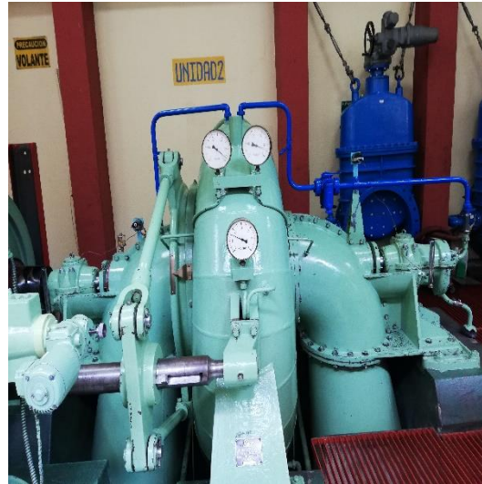
Figura 26. Tubos de aspiración turbina Francis
