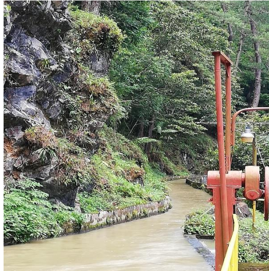
Figura 16. Canal de conducción hidroeléctrica Chichaic
