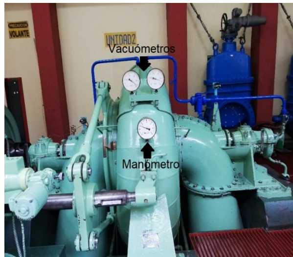
Figura 35. Instrumentación turbina Francis 2
