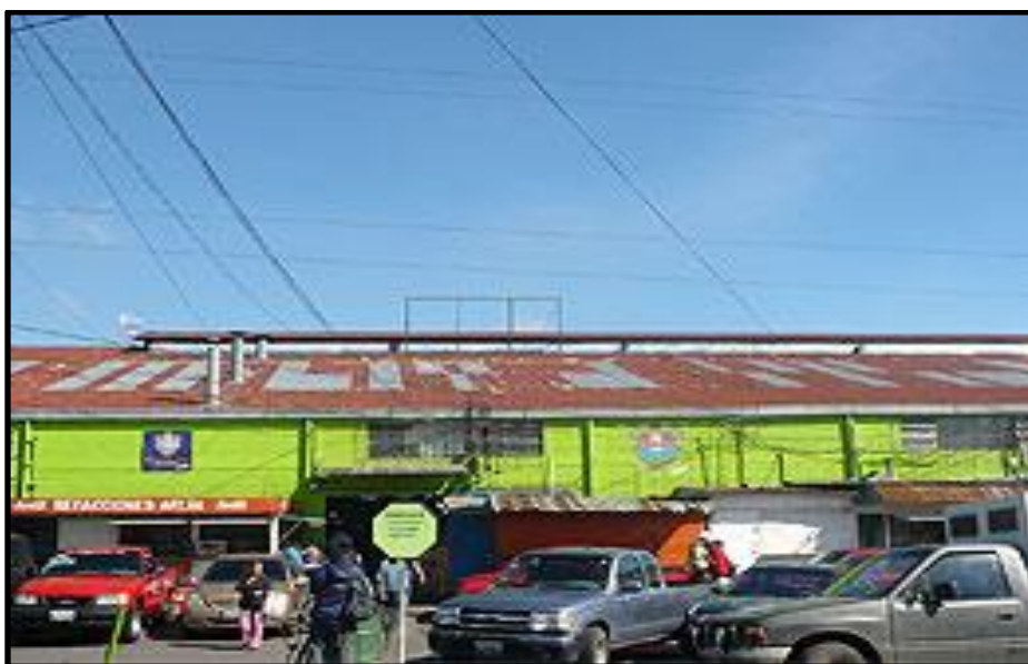
Figura 32. Instalaciones del mercado de la colonia La Florida
