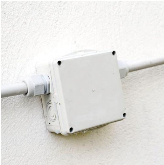
Figura 26. Forma sugerida de instalar caja de registro
