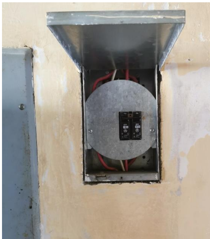
Figura 21. Interruptor termomagnético principal acometida Museo del Libro Antiguo
