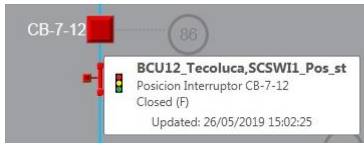
Figura 73. Pantalla de variable digital de control en SCADA
