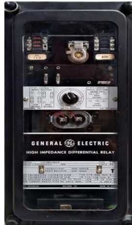
Figura 19. Relevador electromecánico
