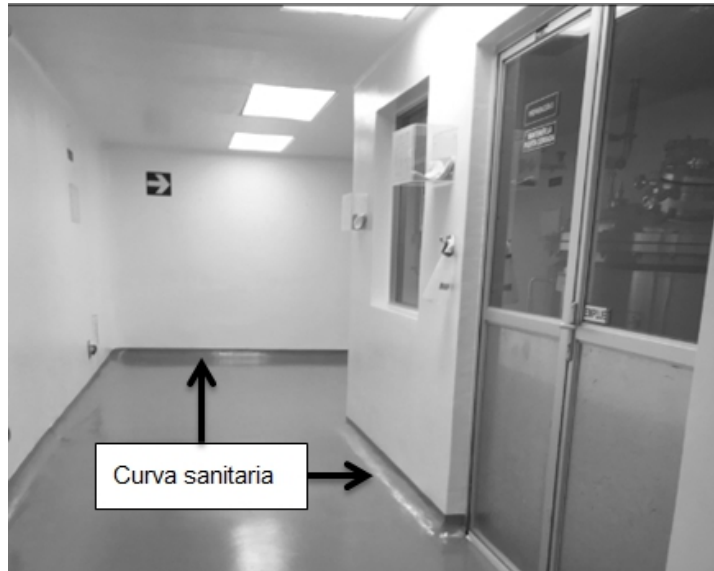
Figura 8. Paredes y piso áreas de producción
