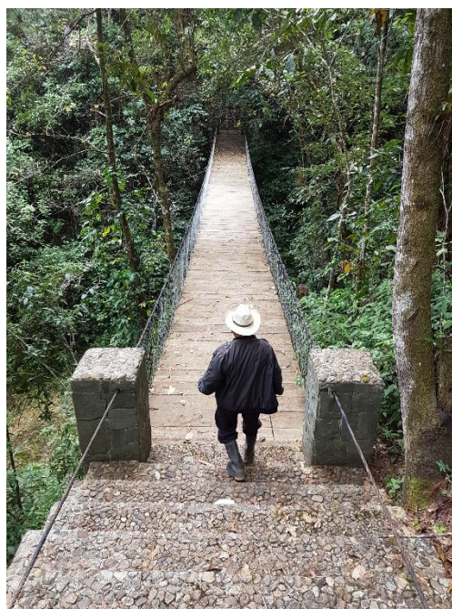
Figura 6. Puente colgante Sector Miramundo II
