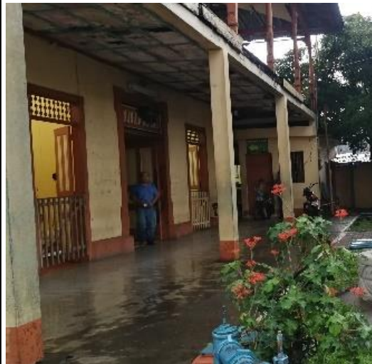
**Figura 18. Corredor Edificio Municipal San Francisco Zapotitlán
