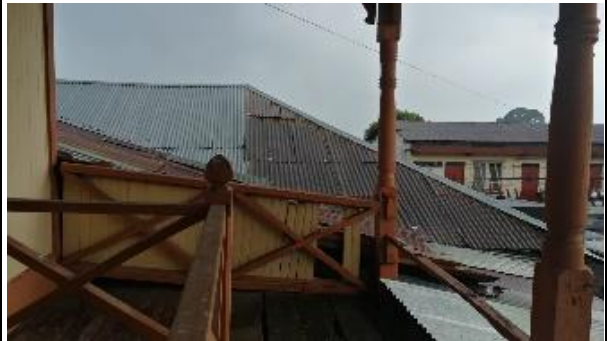
**Figura 16. Techo Edificio Municipal San Francisco Zapotitlán
