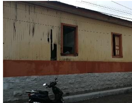
**Figura 20. Posterior Edificio Municipal San Francisco Zapotitlán
