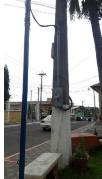
Figura 63. Acometida eléctrica. Fuente: elaboración propia
