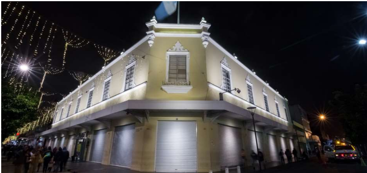
Figura 3.8 Iluminación Edificio administrativo de EEGSA, Guatemala, Guatemala.
