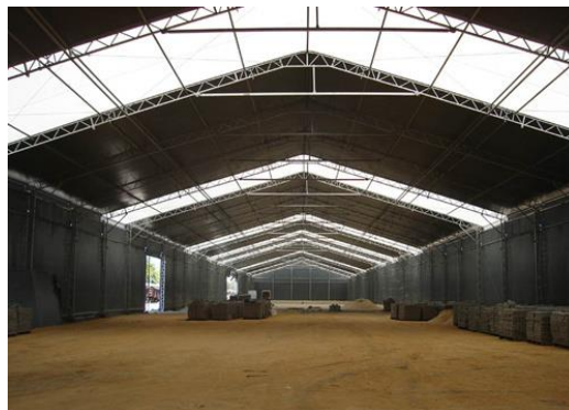
Figura 34. Nave industrial con techo de dos aguas
