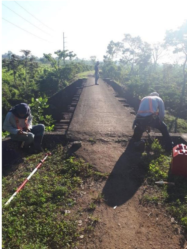
Figura 15. Inicio en puente de la antigua línea férrea
